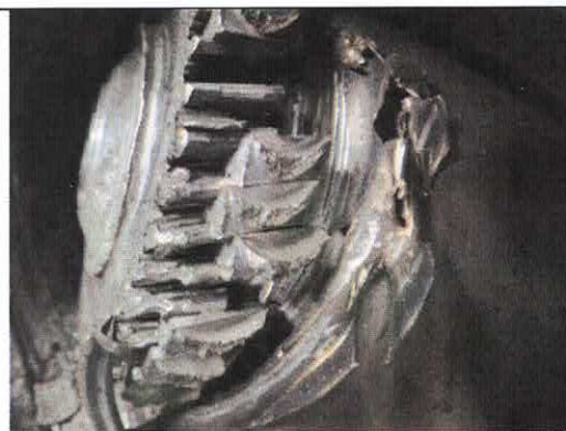
Imagen 21.- Acercamiento a las cuchillas del generador.
