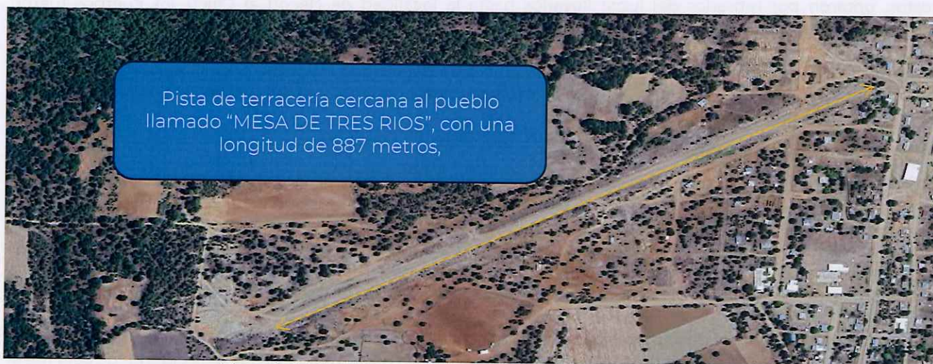
Vista de la pista por la que se pretendía realizar el aterrizaje
