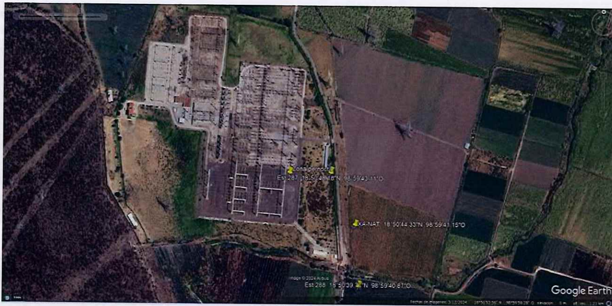
Imagen 2. Instalaciones de la Subestación eléctrica de Yautepec Potencia
