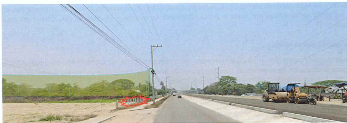
Imagen 2 Cables de corriente eléctrica en trayectoria de vuelo.
