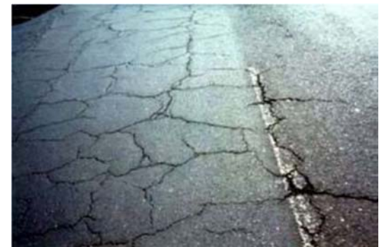
Figura 3.1.7. Agrietamiento forma
