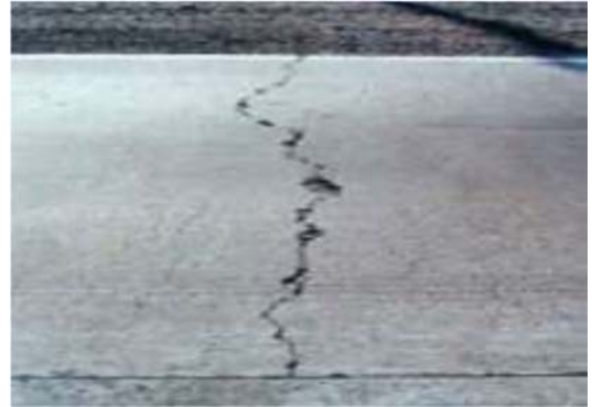
Figura 3.1.18. Grietas transversales
