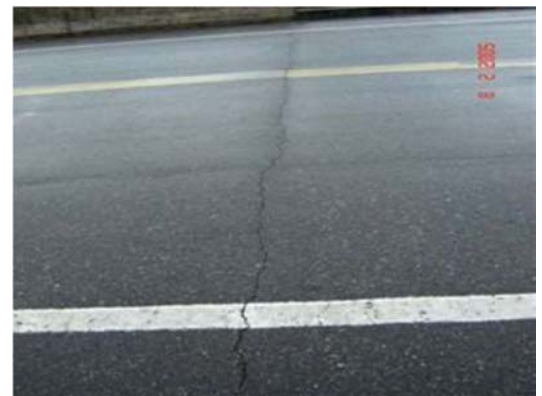
Figura 3.1.6. Agrietamiento Transversal
