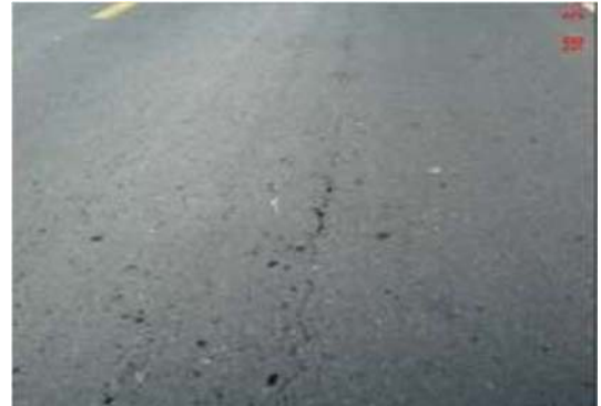
Figura 3.1.5. Agrietamiento
