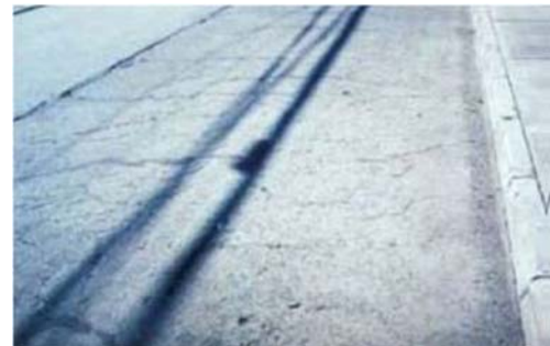
Figura 3.1.17. Grietas diagonales
