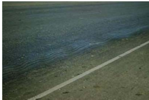
Figura 3.1.10. Deformación transversal
