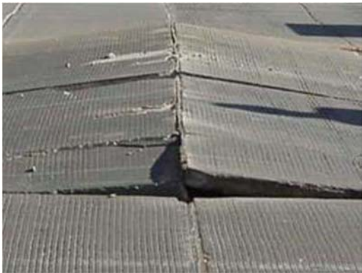
Figura 3.1.20. Levantamiento de losas
