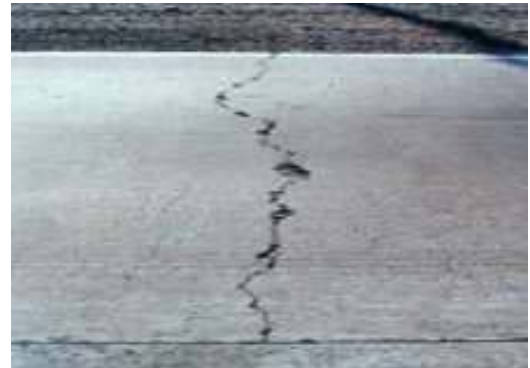
Figura 3.1.18. Grietas transversales
