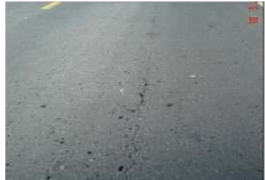
Figura 3.1.5. Agrietamiento
