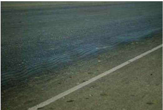
Figura 3.1.10. Deformación transversal
