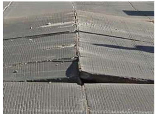
Figura 3.1.20. Levantamiento de losas
