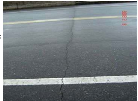
Figura 3.1.6. Agrietamiento Transversal
