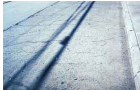
Figura 3.1.17. Grietas diagonales
