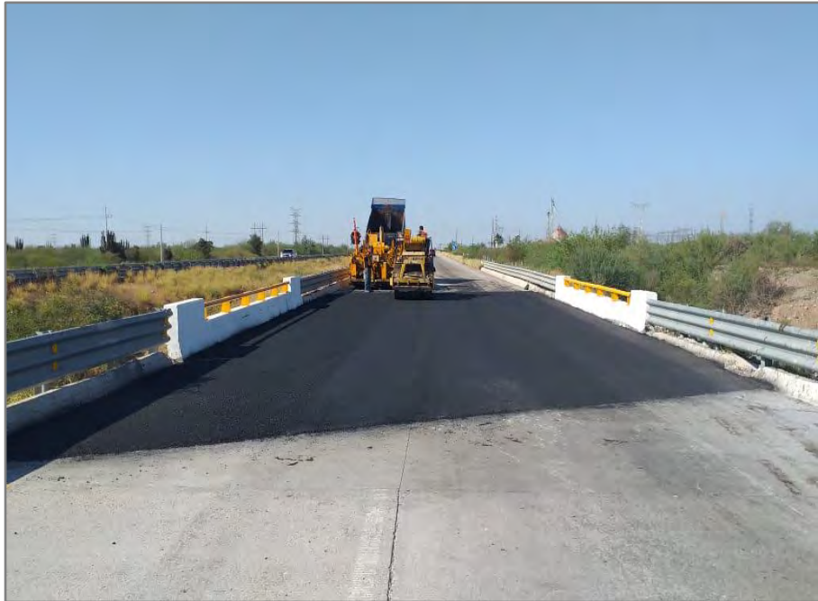
Puente Malcobaso, km 131+518
