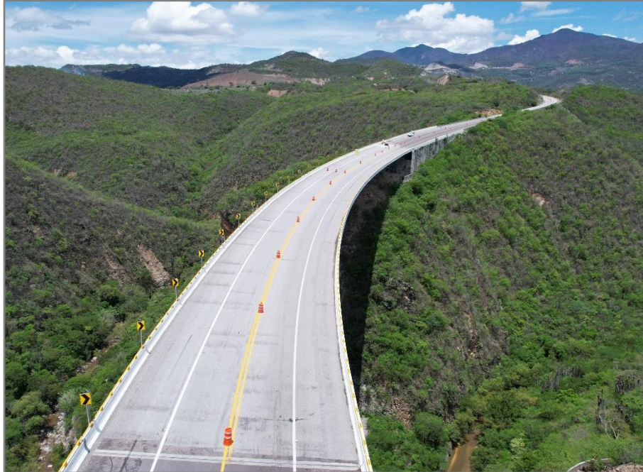
Puente El Horganal, km 68+450
