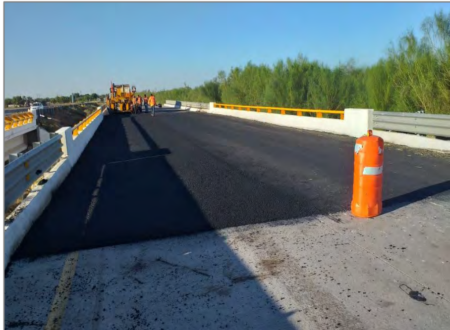
Puente El Gallo, km 144+950
