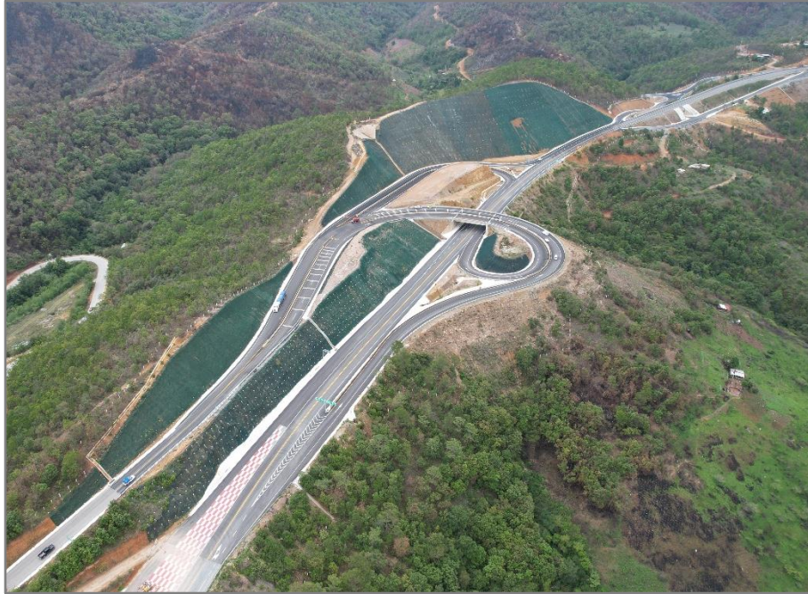
Entr. Ayutla, km 81+642
