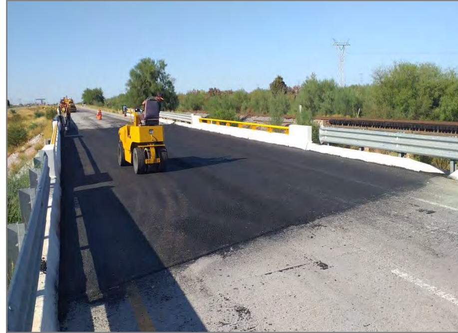
Puente Colosal, km 128+280
