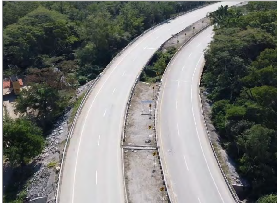
Puente "Covadonga", km 370+075
