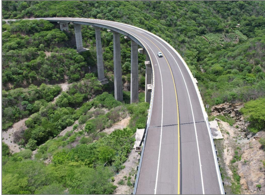
Puente Lachiguiri, km 165+560
