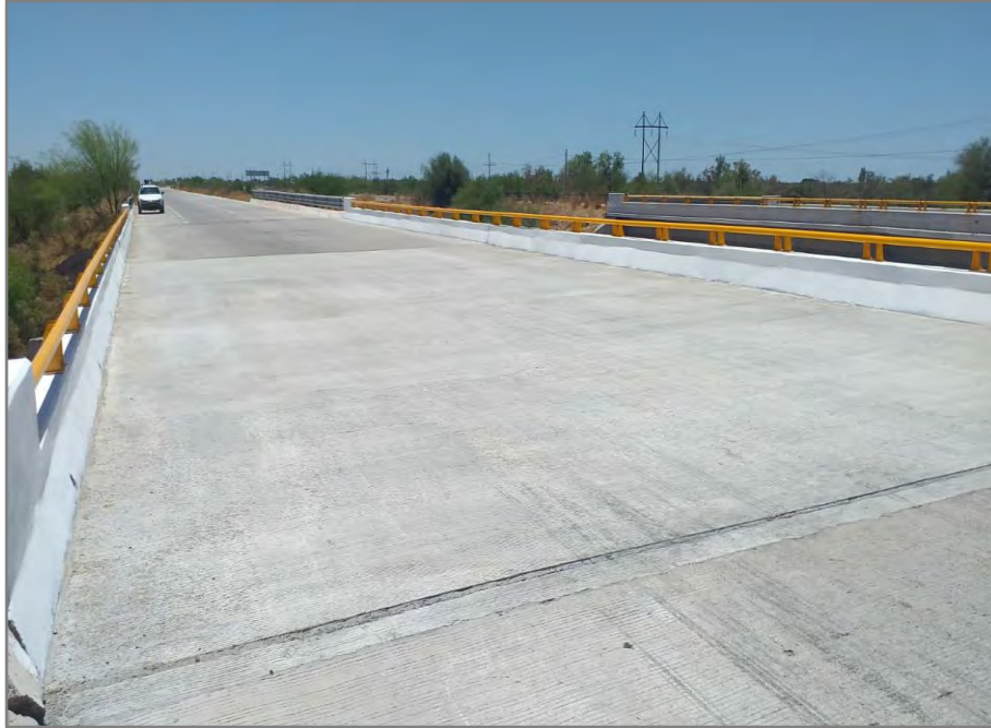
Puente La Gallina, km 125+680
