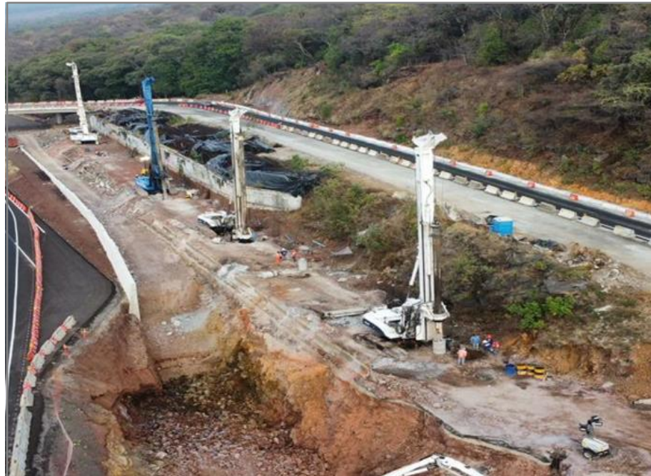
Muro de contención con 218 pilotes, km 70+700
