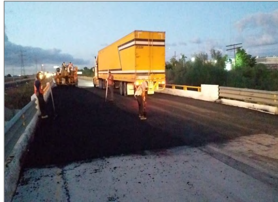
Puente Sin Nombre, km 148+240
