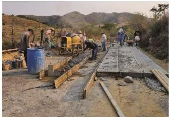
Trabajos de pavimentación mediante la construcción de huellas de rodamiento de concreto hidráulico con mano de obra local.
