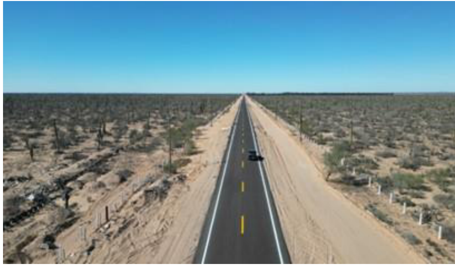
Carretera Federal Santa Rosalía-Guerrero Negro MEX-001, tramo: Vizcaíno-Guerrero Negro, Baja California Sur.
