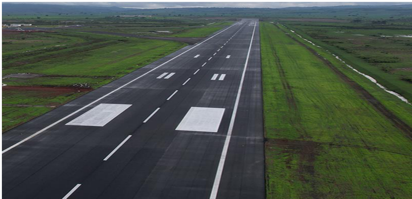
Ampliación de 300 metros de pista en el aeropuerto de Tepic.
