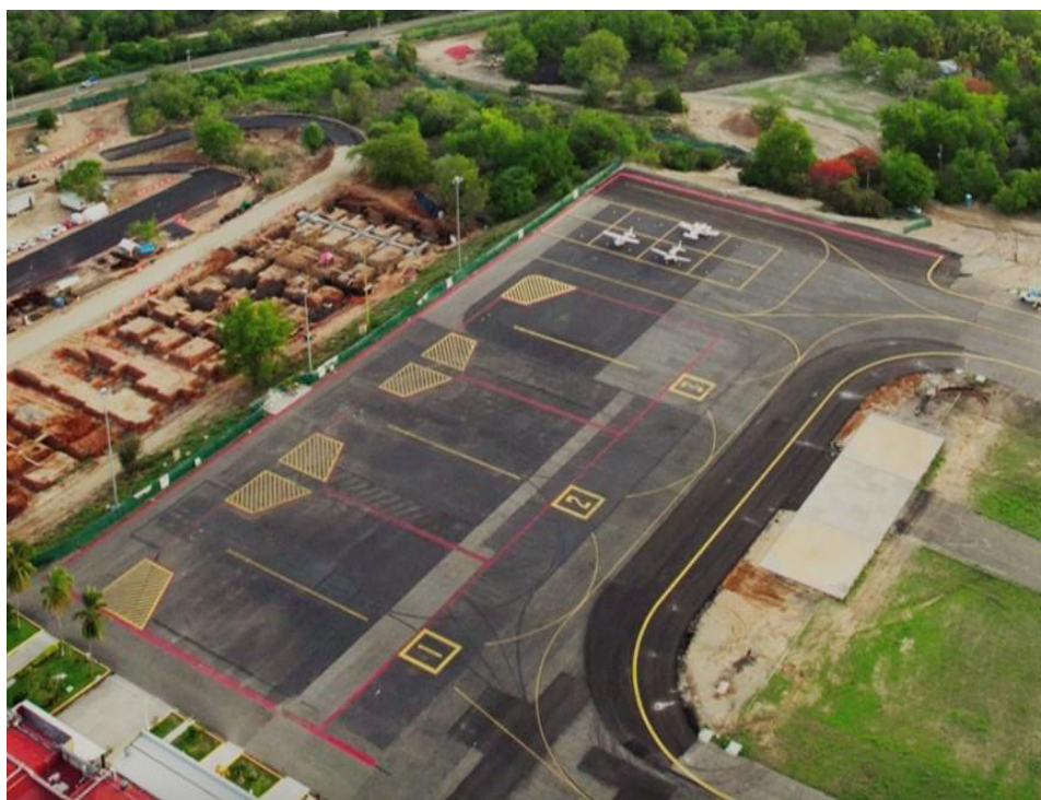
Ampliación de reconfiguración de la Plataforma Comercial del aeropuerto de Puerto Escondido.
