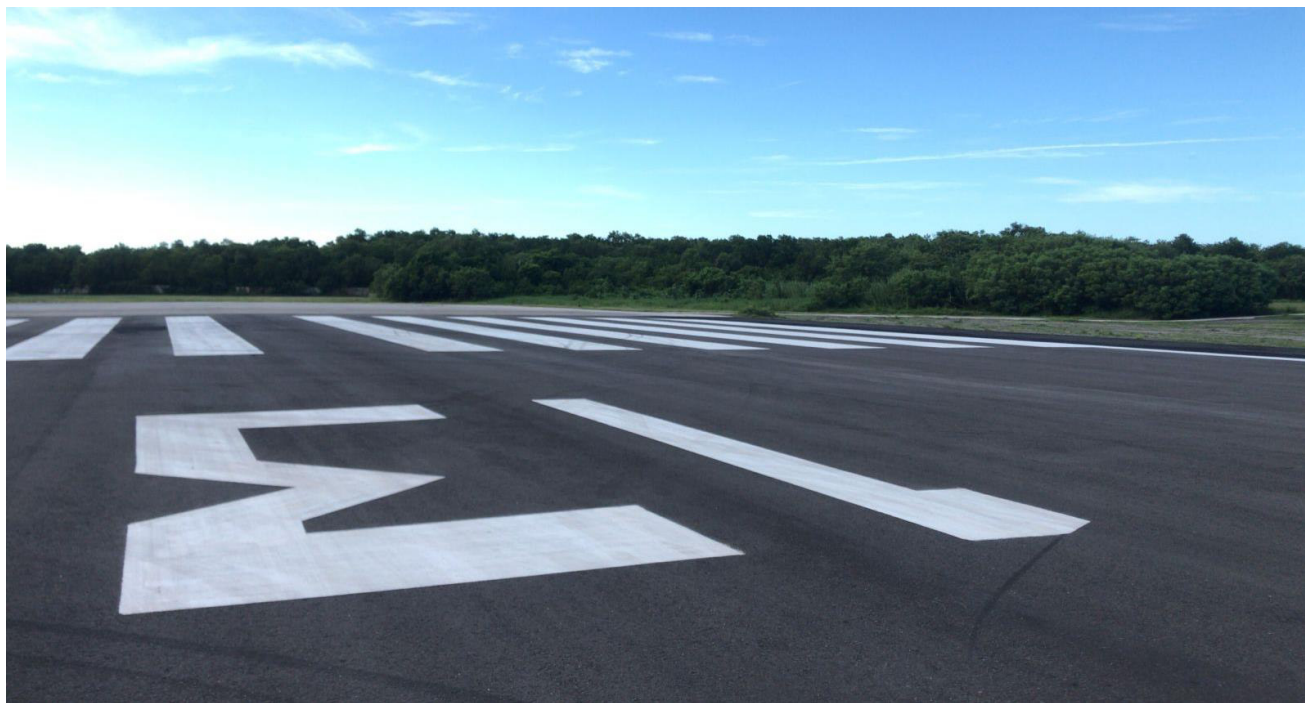
Rehabilitación de pista en el aeropuerto de Ciudad del Carmen, Campeche.
