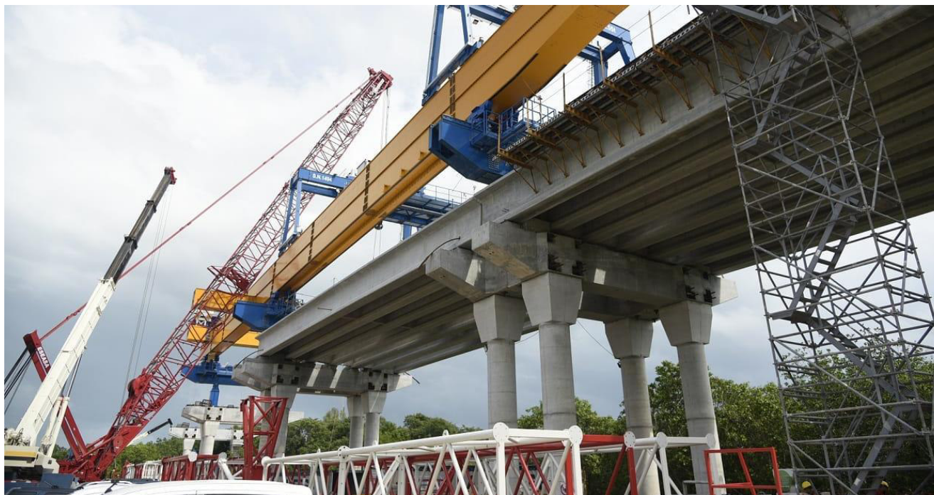
Avance de construcción del Puente Vehicular Nichupté, en Quintana Roo.
