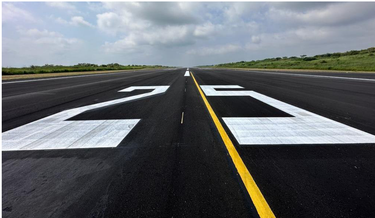
Rehabilitación de pista en el aeropuerto de Colima, Colima.
