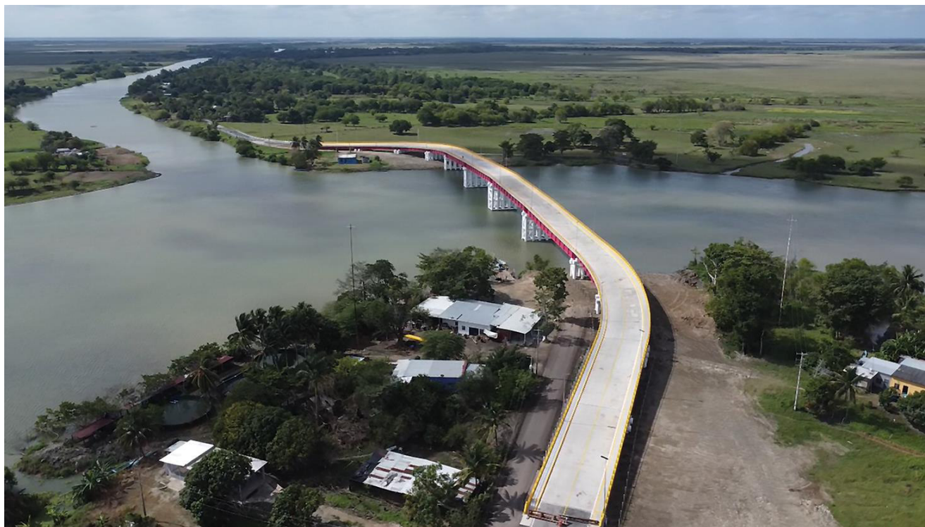
Puente Quintín Arauz en Tabasco.
