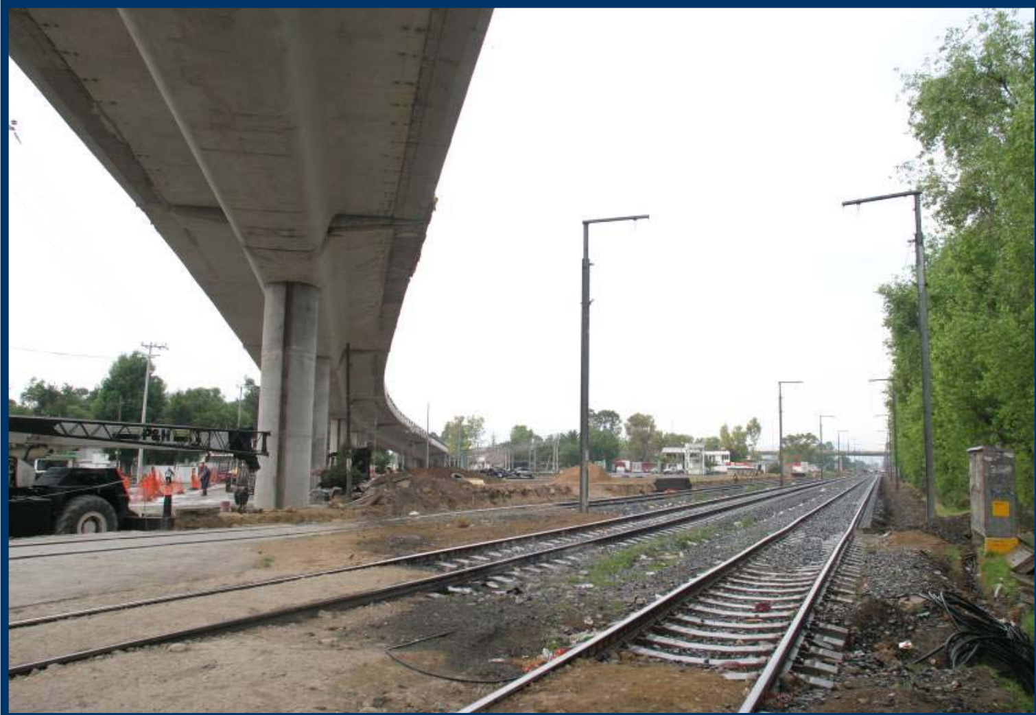
Tren Suburbano, México. Tramo: Buenavista-Cuautitlán.
