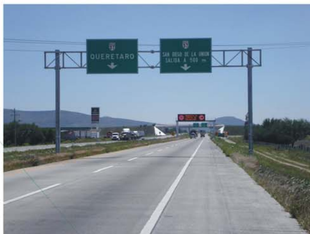
Carretera: Querétaro - San Luis Potosí, Gto. Tramo: Límite de Estados Qro./Gto.- Límite de Estados Gto./S.L.P.
