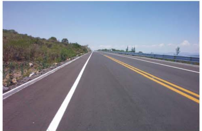
Autopista: Morelia - Salamanca, Mich. Tramo: Copándaro - Entronque la Cinta.
