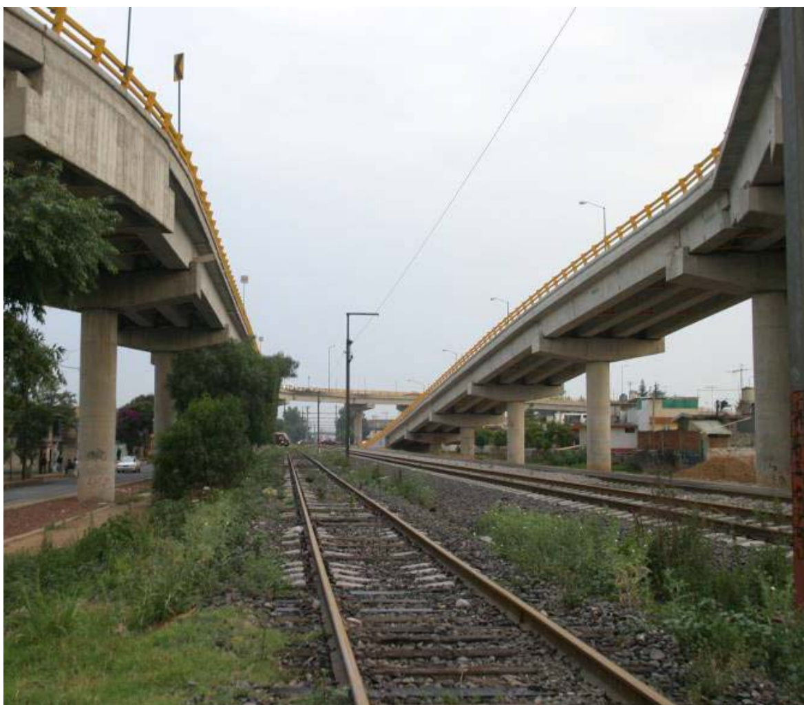
Tren Suburbano, México. Tramo: Buenavista-Cuautitlán.
