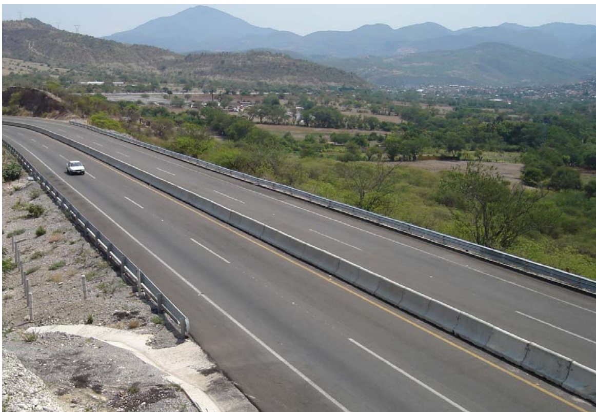
Carretera: Cuernavaca-Chilpancingo, Guerrero. Tramo: Zumpango-Chilpancingo.
