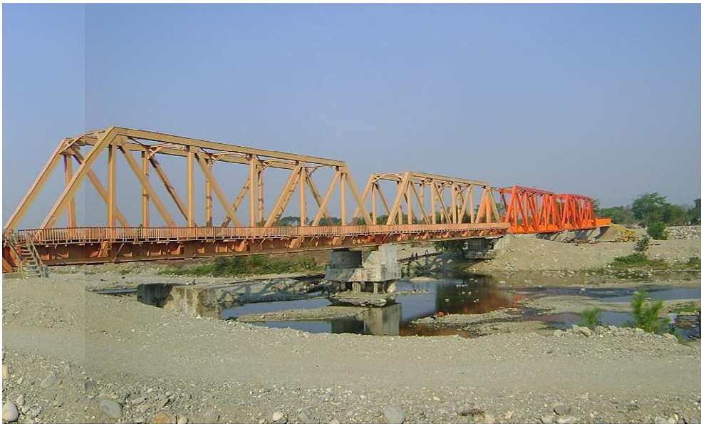
Reconstrucción del puente Pijijiapan en Chiapas. (Ferroca-rril del Istmo de Tehuantepec)
