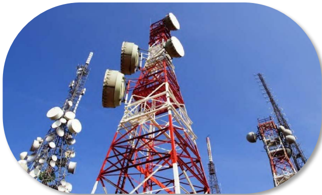
Antenas de Telecomunicaciones
