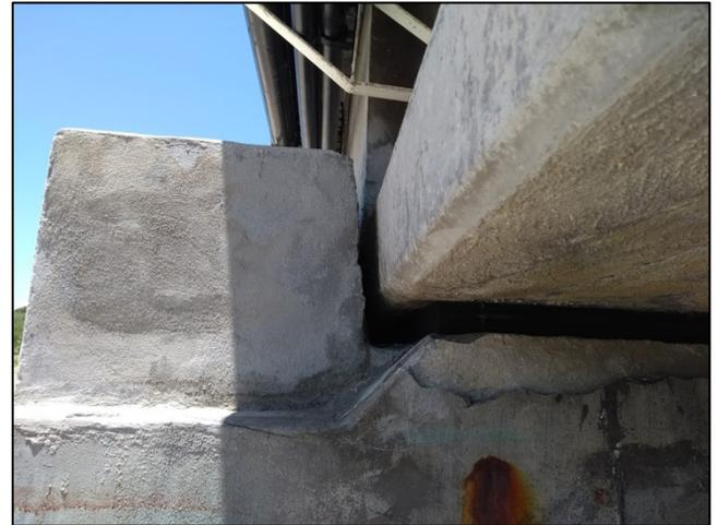
Figura 3. Topes sísmicos tipo ménsula donde existe separación no conveniente entre trabes y tope en caballete
