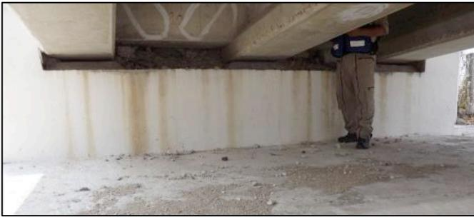
Figura 4. Topes sísmicos tipo viga en caballete extremo
