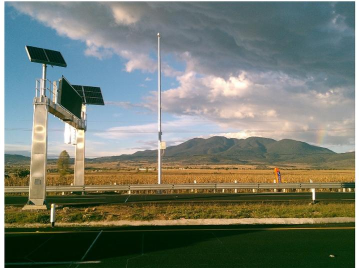
**Figura 1. Estación de toma de datos, cámara de video-vigilancia y panel de mensaje. Carretera Atlacomulco-Maravatío, km 108+450**
