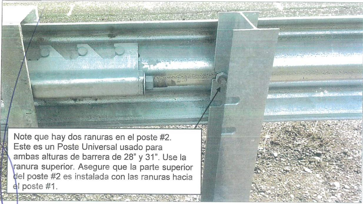
Note que hay dos ranuras en el poste #2. Este es un Poste Universal usado para ambas alturas de barrera de 28" y 31". Use la ranura superior. Asegure que la parte superior del poste #2 es instalada con las ranuras hacia el poste #1.
