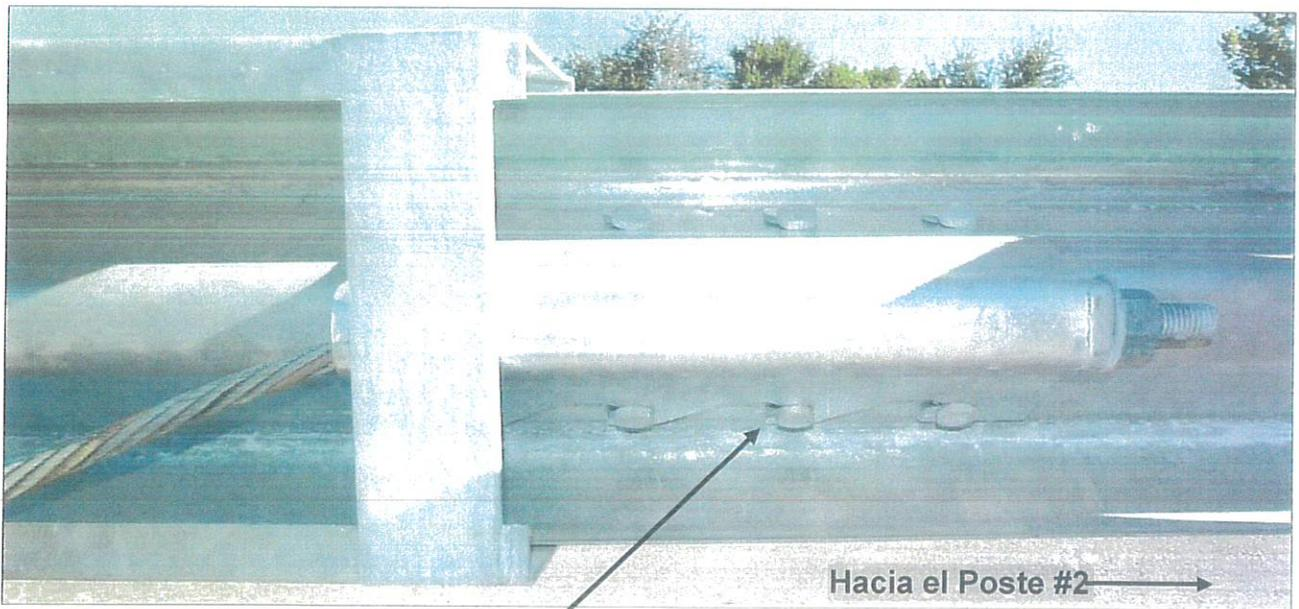
Es importante que el soporte para anclaje este completamente apoyado en el tope de los pernos
