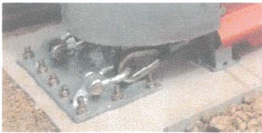
Placa de sujeción de cable ensamblada
