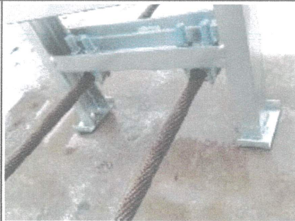
Abrazadera de cable y soporte de rotación ensamblados
