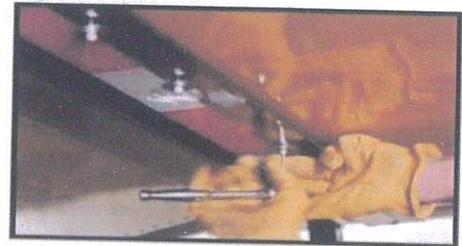
7. Asegurar la caja de conexión y atornillar la abrazadera arriba del Módulo C. Una vez asegurado conectar el cable de electricidad a la caja de conexión.
