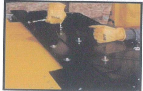
9. Cortar el cincho de seguridad que sostiene el cable de electricidad y adjuntar al cable que está ubicado en parte posterior del Módulo A. Usando cinchos, asegurar los cables a la parte superior del Módulo A.
