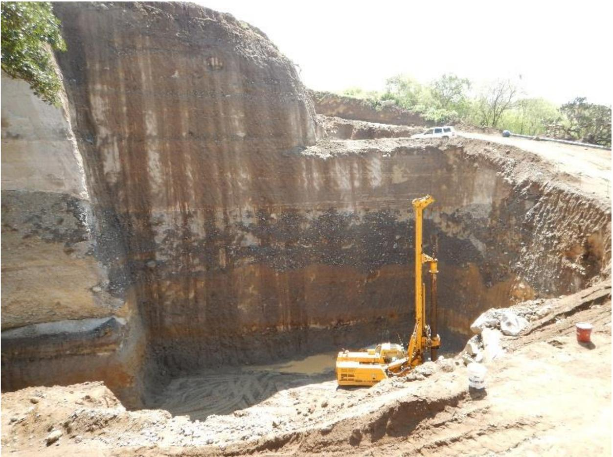
Figura 6.50 Cortes y trabajos de excavación para la cimentación del Puente durante el procedimiento constructivo.
