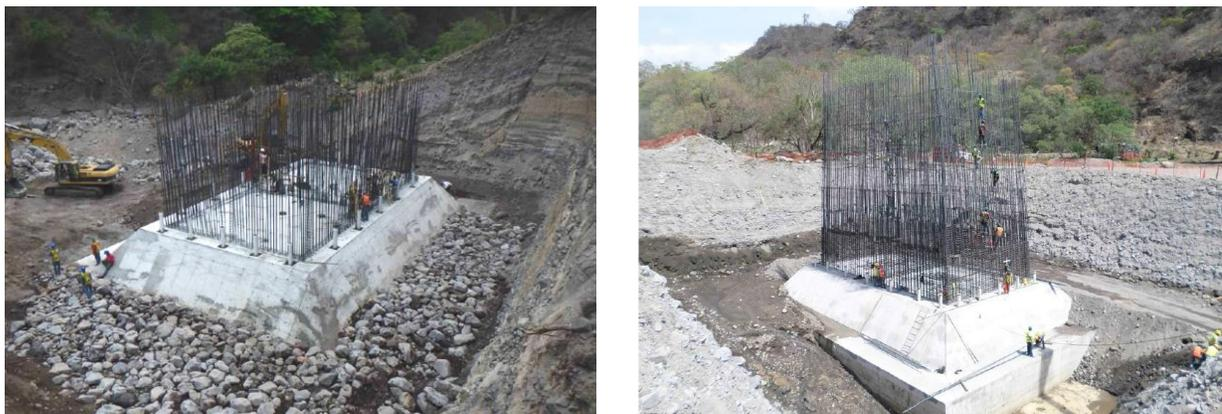
Figura 6.6 Cimentación superficial construida para un puente especial desplantada sobre suelo friccionante.
