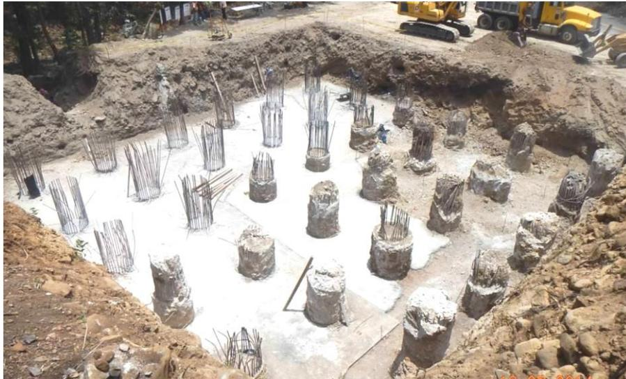
Figura 6.31 Grupo pilas de cimentación coladas en sitio en suelos friccionantes.
