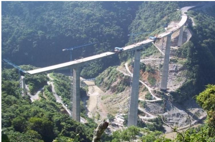
Figura 3.3 Puente San Marcos: puente en doble volado, Carretera México-Tuxpan, Hidalgo, México, 2013.
