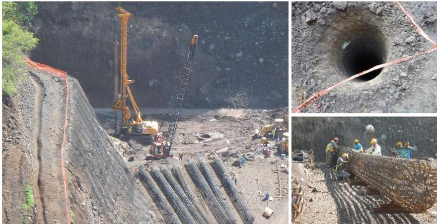
Figura 6.13 Trabajos de perforación para pilas de cimentación coladas en sitio.
