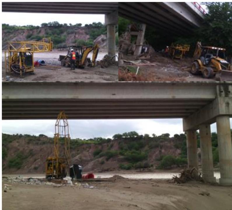
Figura 4.3 Maniobras de arrastre de equipo de perforación, con maquinaria pesada.
