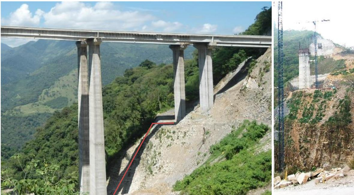
Figura 6.16 Cimentación desplantada sobre talud.
