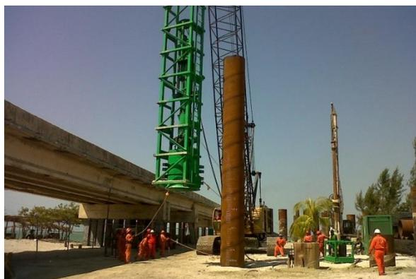
Figura 6.11 Hincado de pilote de acero de 1.20 m de diámetro con martinete hidráulico de acción simple para cimentación de puente.
