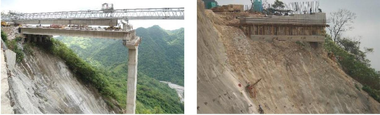
Figura 6.49 Protección y estabilización de taludes para estribo de puente.
