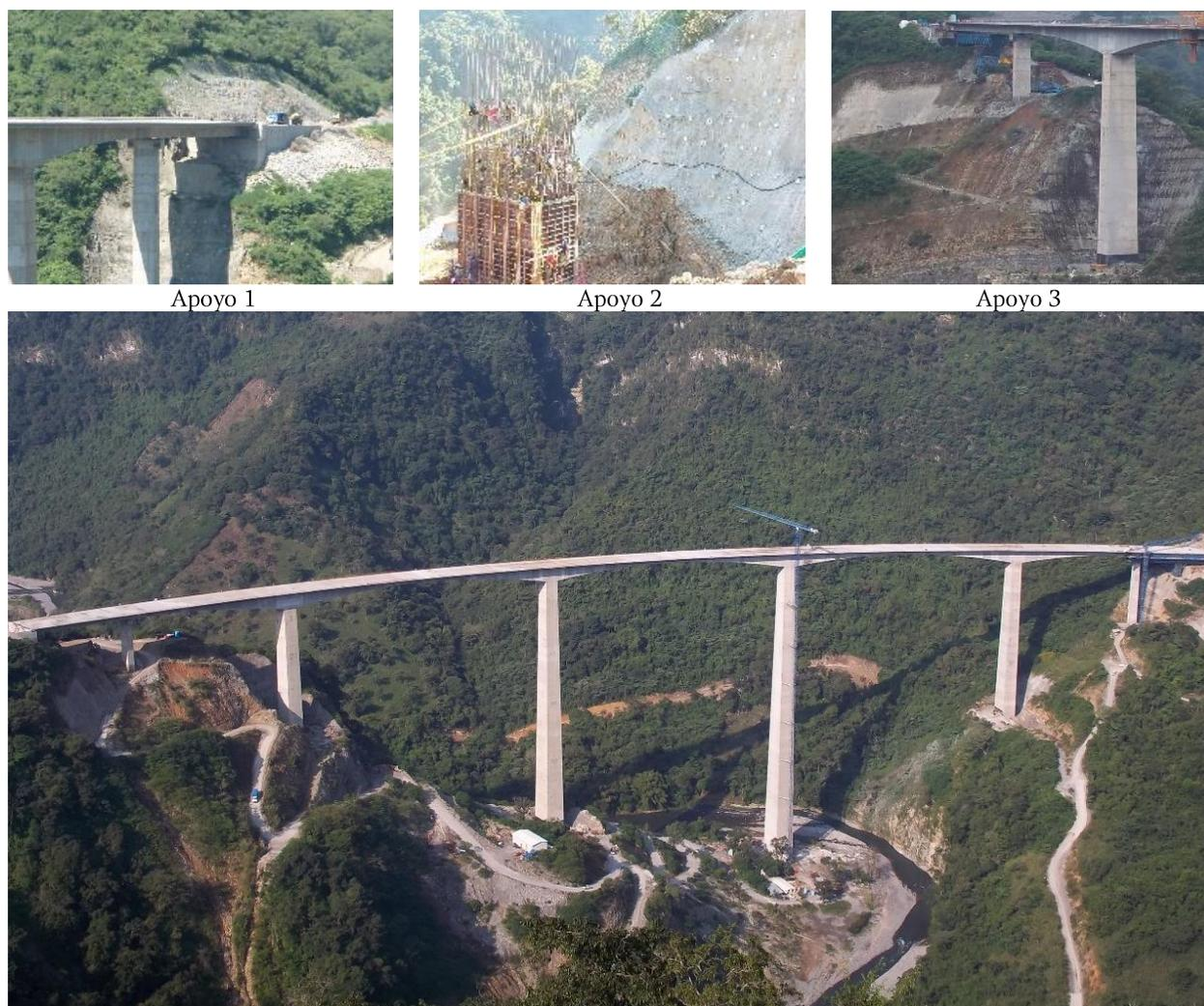
Figura 4.2 Puente especial en doble volado, se identifican los detalles geotécnicos de cada uno de los apoyos: desplante sobre talud, en presencia del NAF, estabilización de taludes, muros de contención y caminos de acceso.
