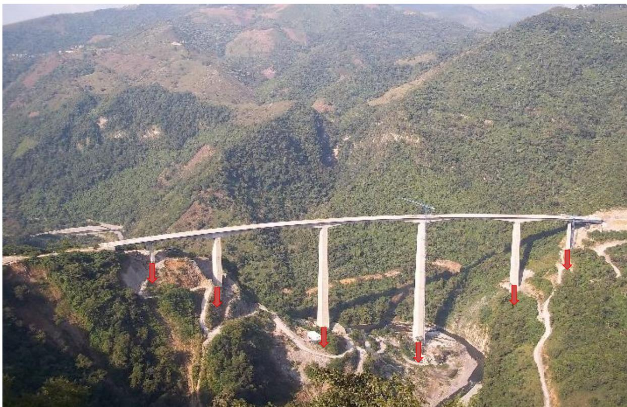
Figura 4.6 Ubicación de sondeos en zona accidentada sobre el eje longitudinal del Puente.
