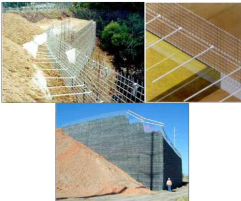
Figura 5.- Muro Mecánicamente Estabilizado con paramento de malla metálica
