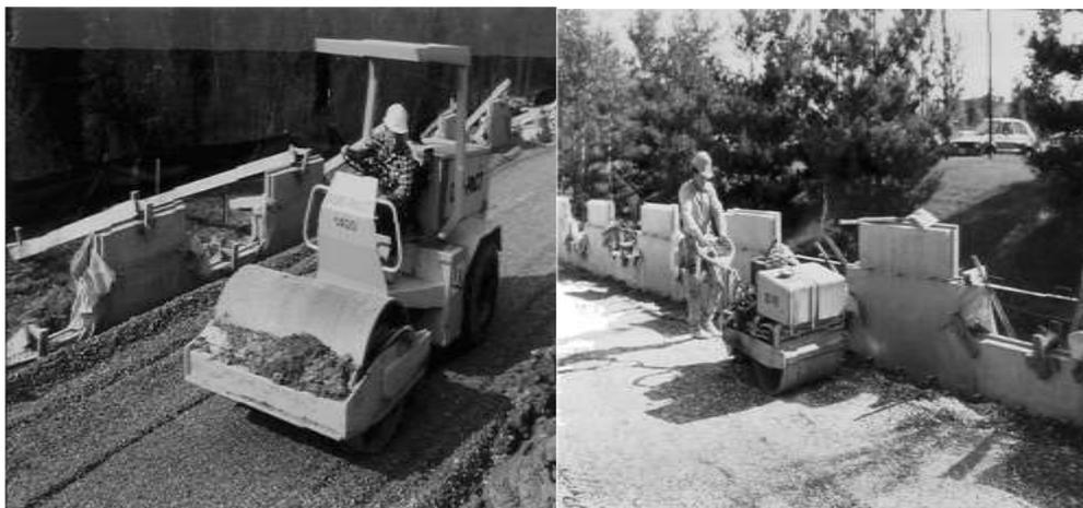
Figura 55.- Equipo de compactación, se muestra: a) Equipo grande sólo permitido si está alejado del paramento; b) Equipo ligero dentro del 1 m de separación del paramento
