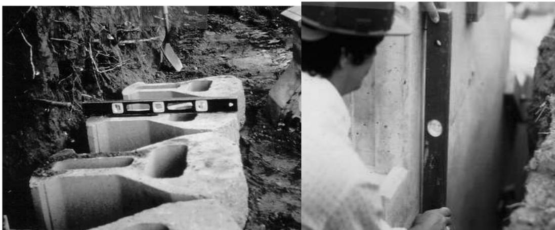
Figura 66.- Revisión del plomo y alineamiento de los elementos del paramento
