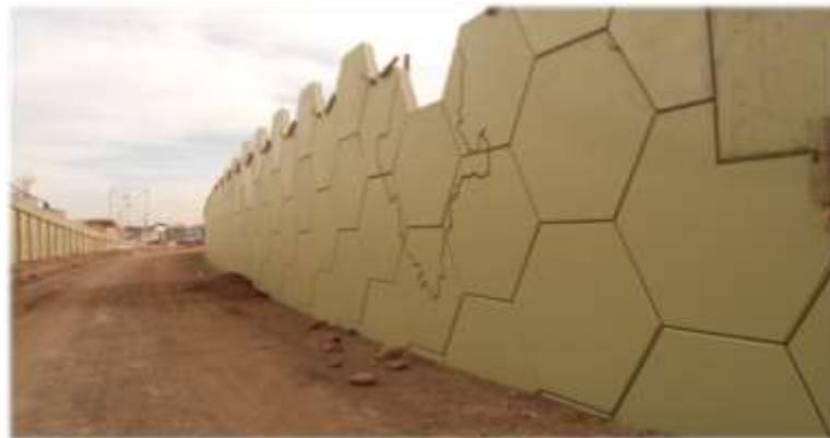
Figura 14.- Panel semi rígido, paneles segmentados
