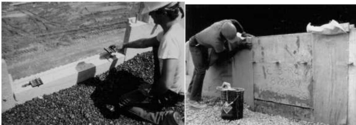
Figura 59.- Colocación de geotextil y almohadillas de neopreno de juntas
