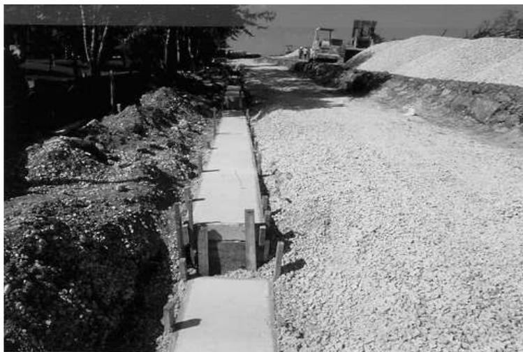
Figura 65.- Dala de nivelación de concreto
