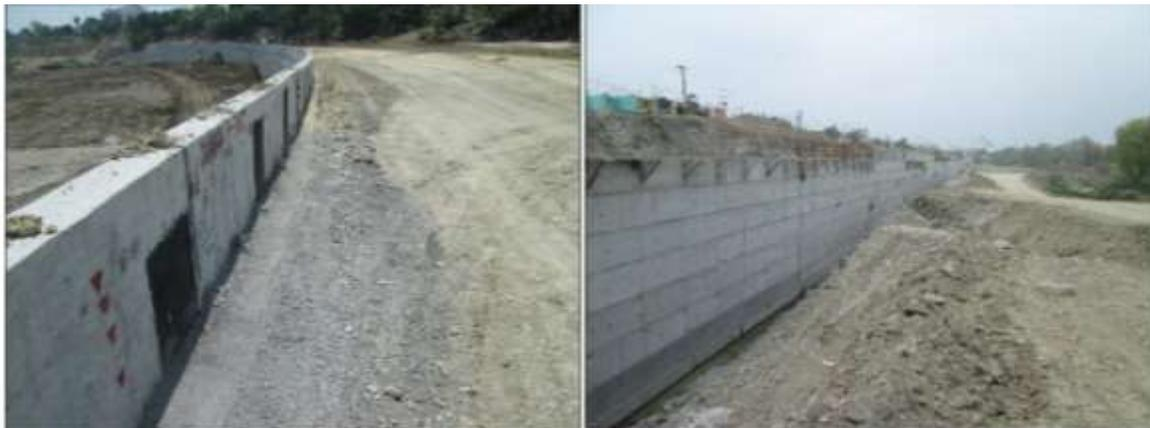
Figura 4.- Paramento de concreto colado en sitio
