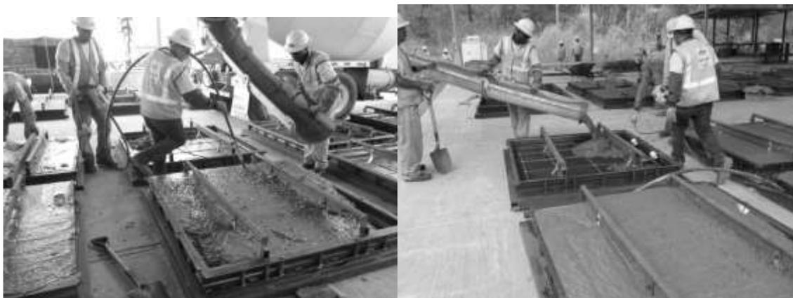
Figura 57.- Patio de colado para elementos prefabricados del paramento
