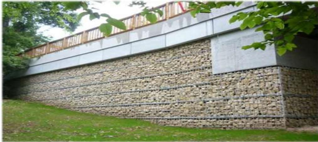
Figura 13.- Panel flexible conformado por mallas
