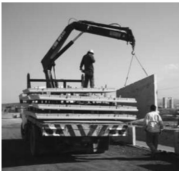
Figura 56.- Izaje y montaje de paneles prefabricados para M.M.E.
