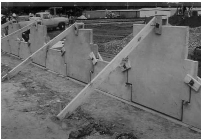
Figura 68.- Colocación de la primera fila de elementos prefabricados para el paramento
