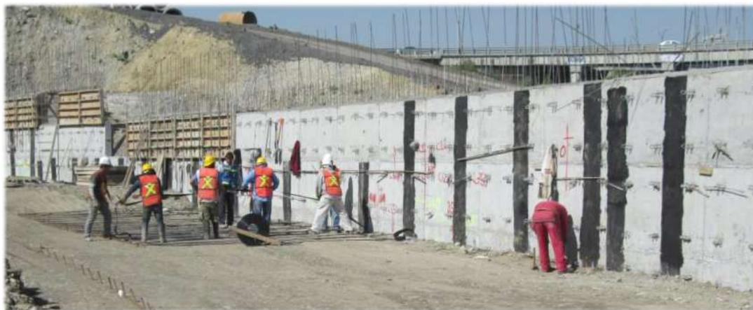
Figura 12.- Panel rígido de concreto
