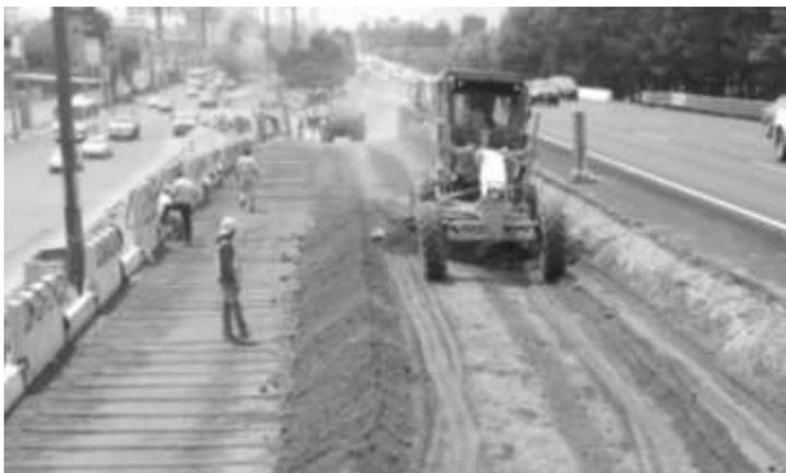
Figura 54.- Tendido de material de relleno con motoconformadora
