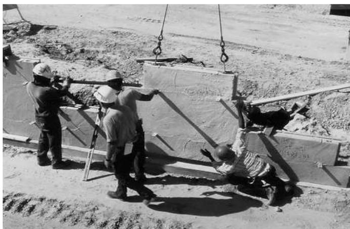
Figura 67.- La colocación de paneles de altura completa requiere cuidado especial en su alineación
