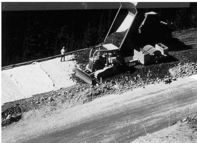
Figura 69.- Colocación de la primera fila de elementos prefabricados para el paramento
