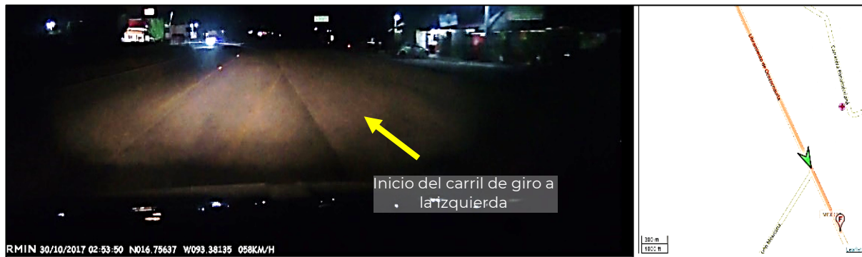
FIGURA 14. Inicio del carril central de giro a la izquierda en el entronque del km 2+000 del Libramiento desde Tapanatepec de noche, circulando a una velocidad de 58 km/h
