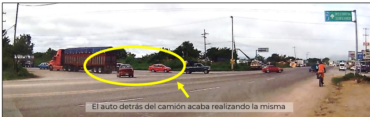
FIGURA 12. Interferencia entre las trayectorias de distintos vehículos circulando por el entronque del km 2+000 del Libramiento
