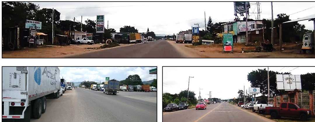
FIGURA 16. Edificaciones, accesos y vehículos estacionados junto a la carretera entre el km 0+000 y el km 4+000 del Libramiento
