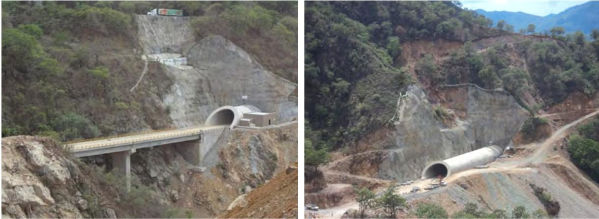
Figura 10.5. Túneles falsos de longitud relativamente corta y de longitud considerable.
