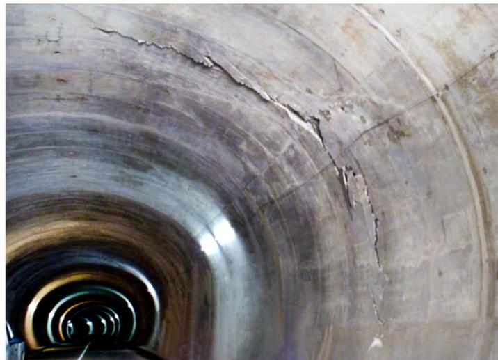
Figura 10.9a. Rotura de la estructura de concreto reforzado.
