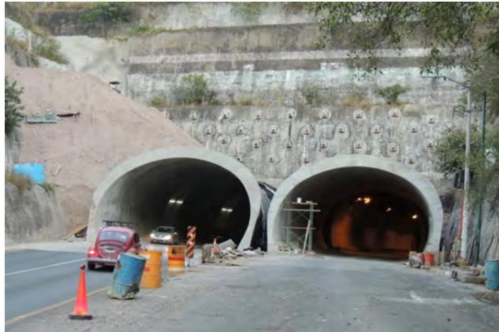
Figura 10.8. Ejemplo de un relleno asimétrico.
