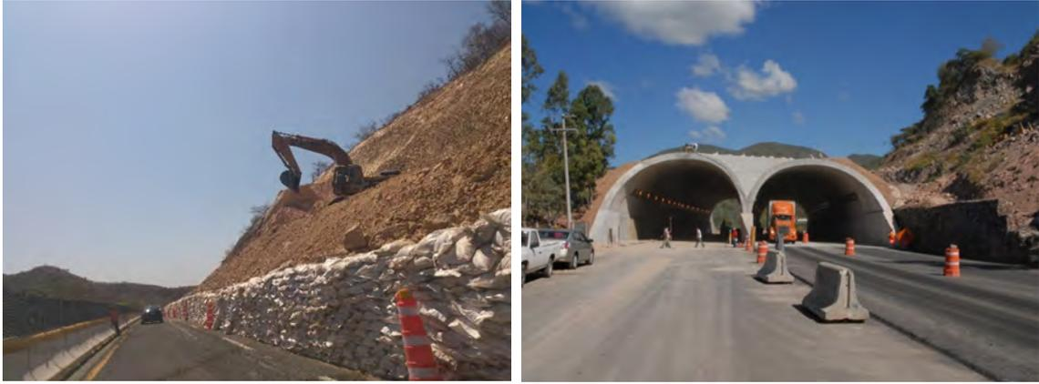
Figura 10.3. Talud inestable y solución con Túneles falsos gemelos, carretera México Acapulco.
