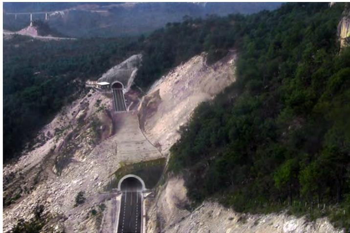
Figura 10.6. Túnel falso en la carretera Durango – Mazatlán.
