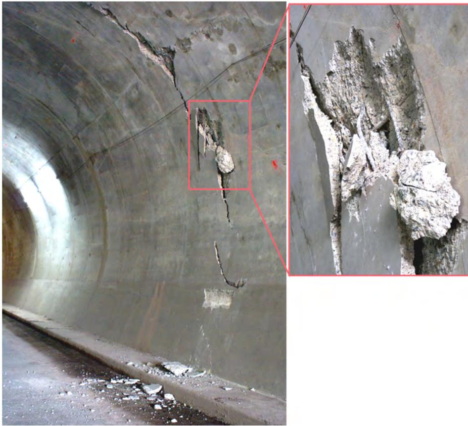
**Figura 10.9b. Rotura de la estructura de concreto reforzado.**
