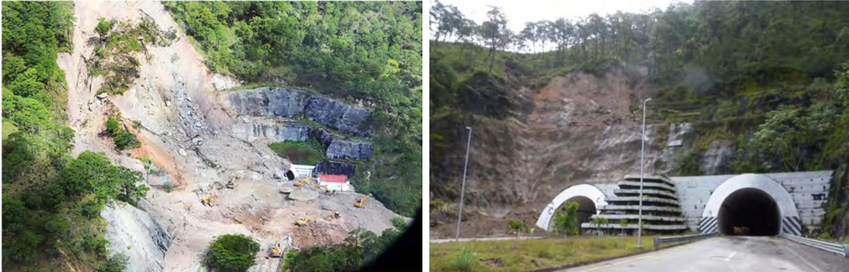
Figura 10.4. Deslizamiento en los portales del túnel Agua de Obispo, septiembre de 2013, (izquierda, portal Acapulco; derecha portal México).
