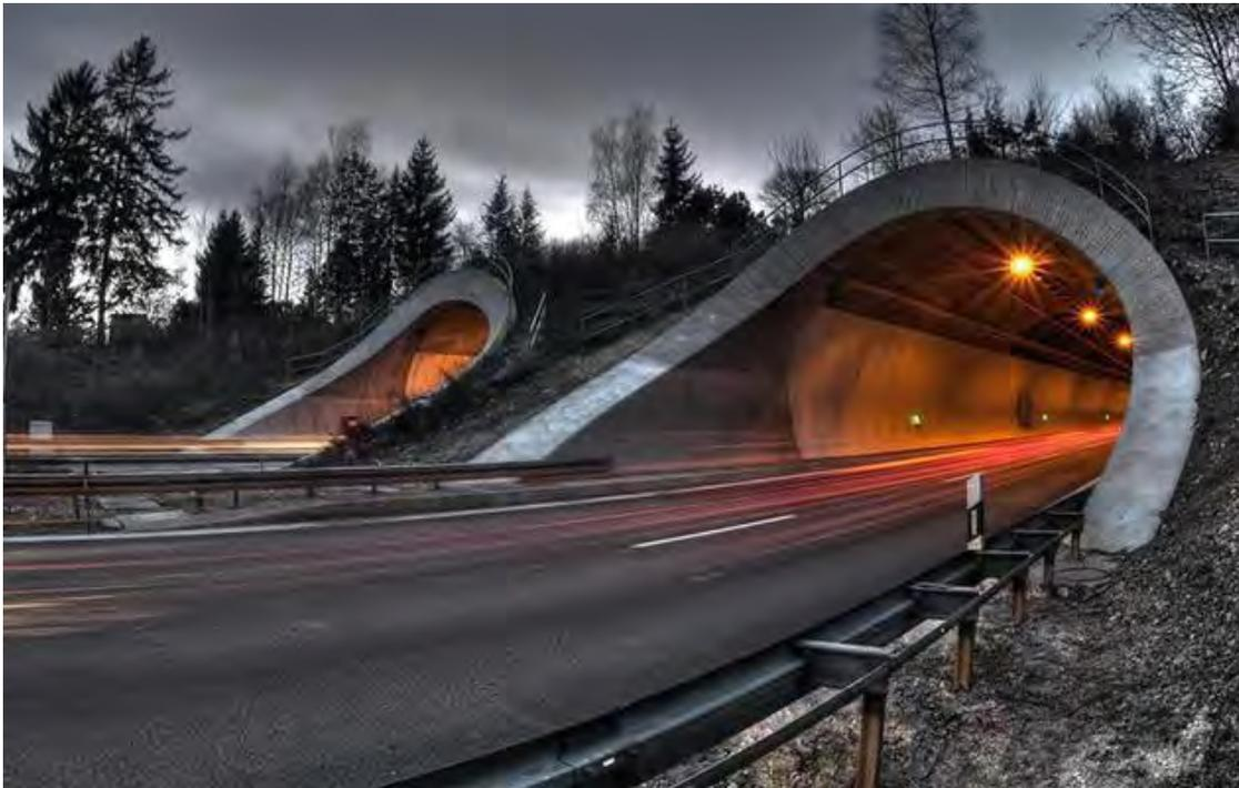
Figura 10.1. Ejemplo de túneles falsos.
