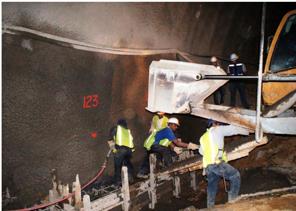
Figura 14.3. Colado de zapatas de concreto hidráulico al interior del túnel.
