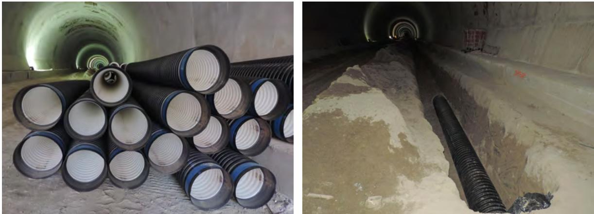
Figura 14.7. Tubería corrugada de polietileno con interior liso para obras de drenaje en túneles.
