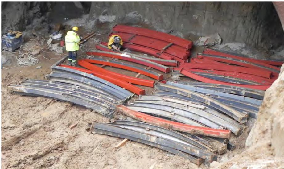
Figura 14.6 Marcos metálicos IPR para utilización en obra
