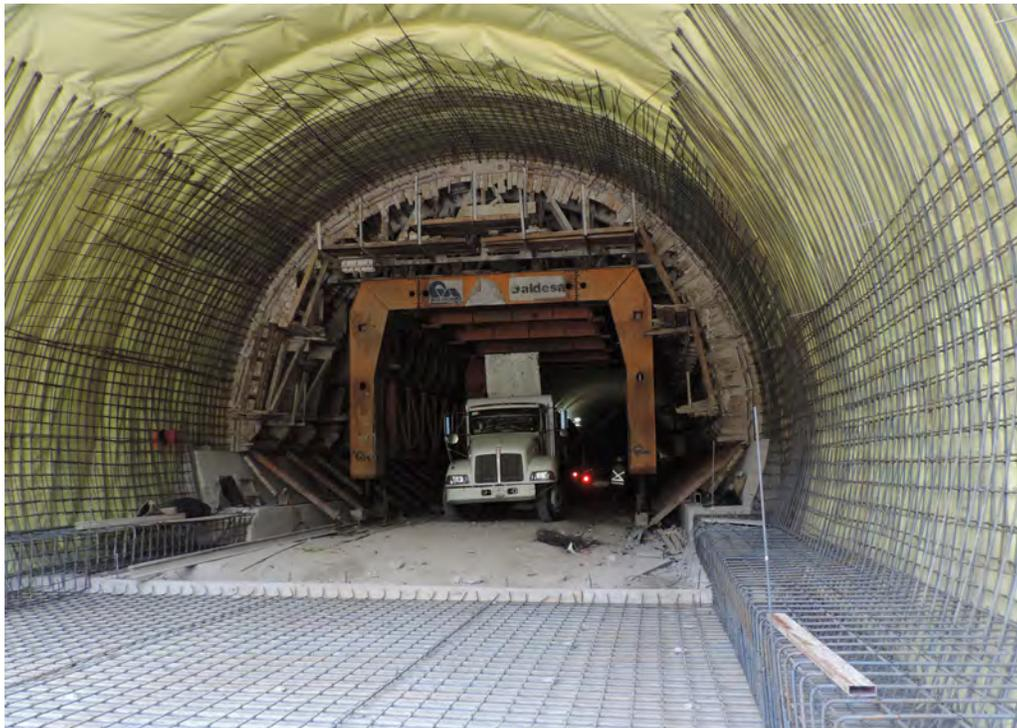
**Figura 14.5. Armado de acero de refuerzo al interior del túnel.**
