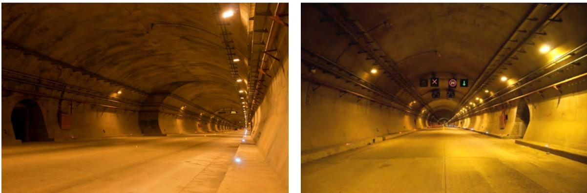
Figura 2.38. Bahía de emergencia y galería de conexión, túnel El Sinaloense.
