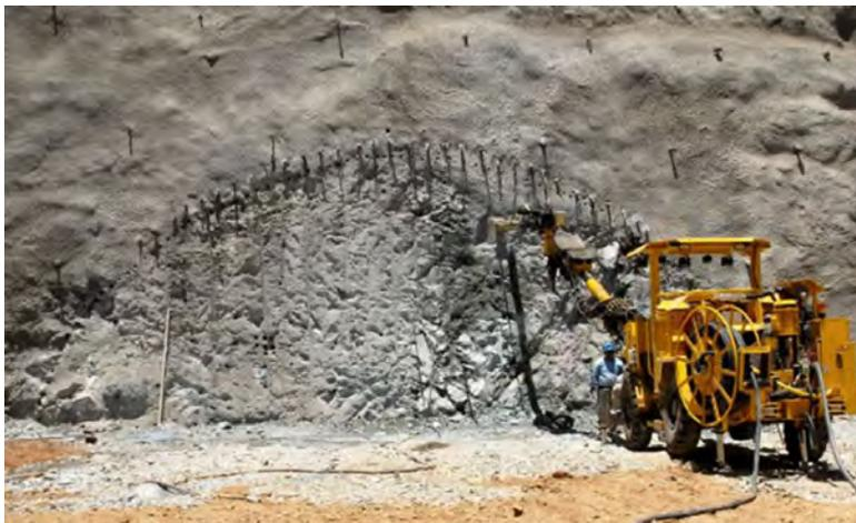
Figura 8.29. Enfilaje ligero en un portal. Túnel Las Palomas, México.
