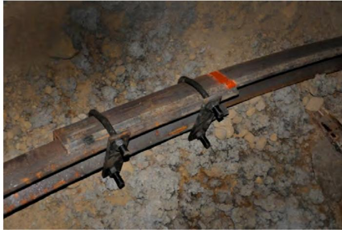
Figura 8.23. Detalle de conexión mediante grapas.
