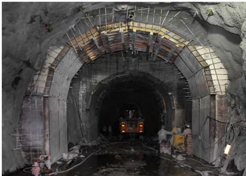
Figura 8.43. Uso de concreto hidráulico como complemento del sostenimiento en condiciones de roca difíciles.
