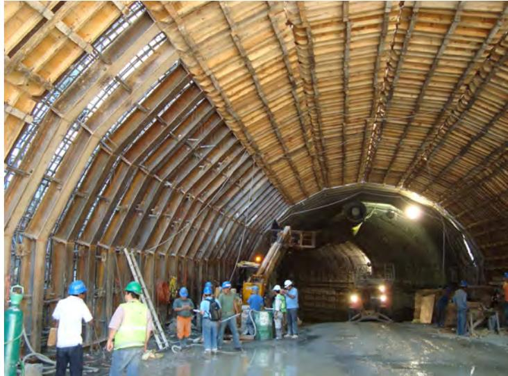
**Figura 8.20. Túnel falso para la obra de desfogue construido con marcos metálicos de viguetas laminadas en caliente y conectadas mediante soldadura. P.H. La Yesca. Nayarit, México. Fuente Comisión Federal de Electricidad (CFE).**
