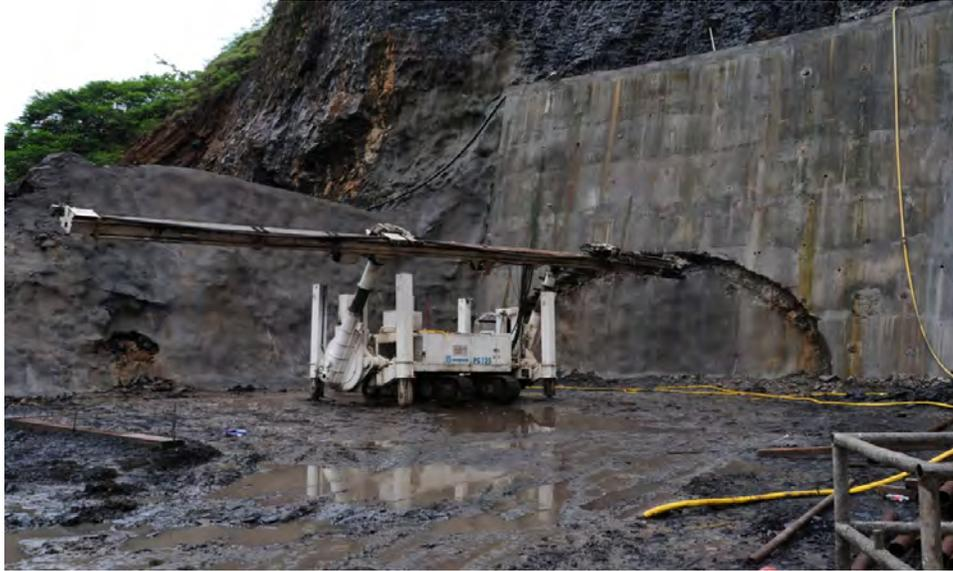
Figura 8.36. Equipo EEPS ejecutando un paraguas de micropilotes en un emportalamiento.
