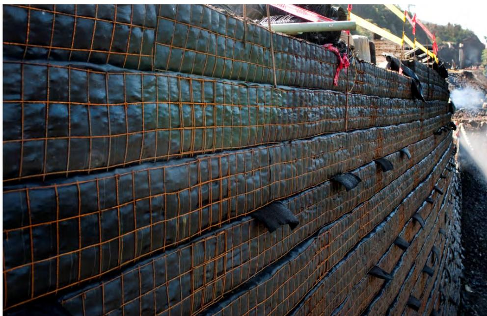
**Figura 9.5. Terraplén reforzado con Geotextiles y malla electrosoldada.**
