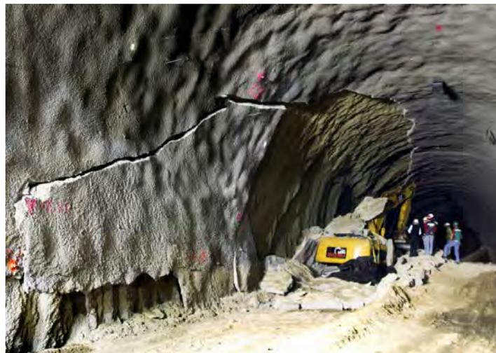
**Figura 9.35. Desprendimiento de concreto lanzado por falta de adherencia. Túnel Interlomas I. Estado de México, febrero de 2014.**
