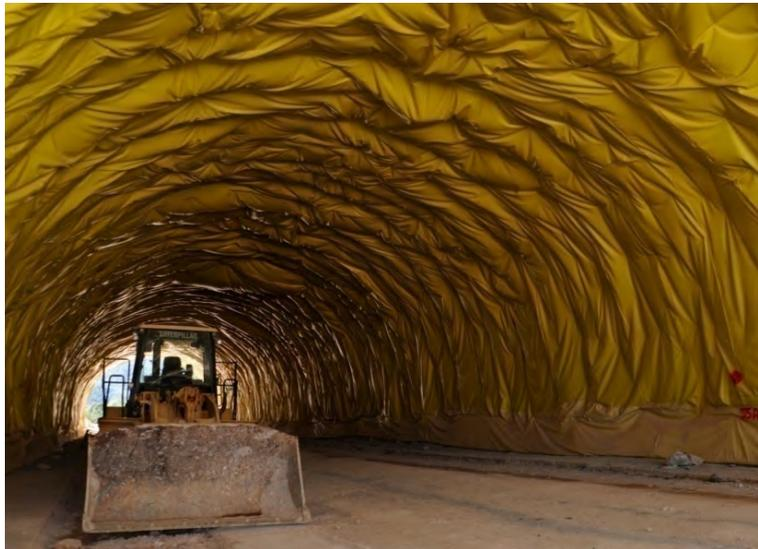
Figura 9.65. Sistema de impermeabilización en un túnel antes del colado del revestimiento.
