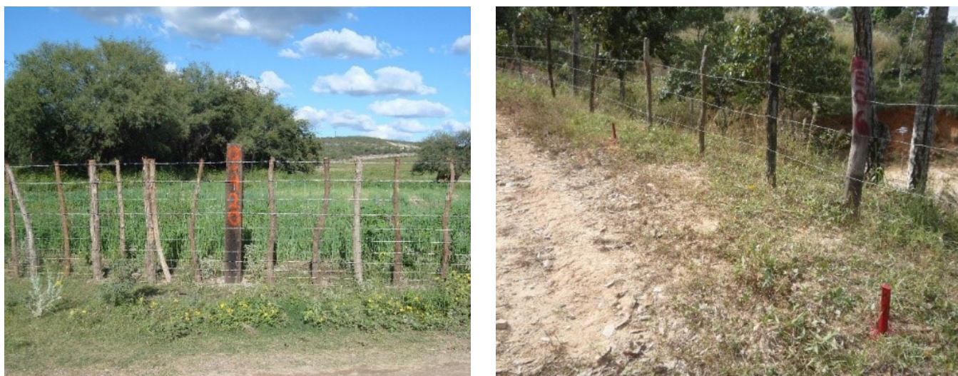
Vista tendido de posteriza y alambrado de acero galvanizado de púas en derecho de vía de carretera.
