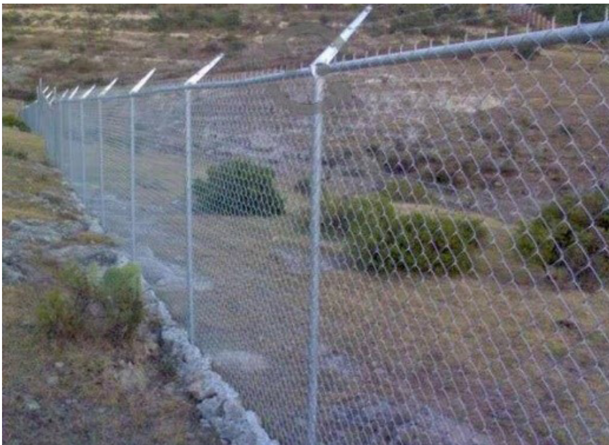
Tendido de malla ciclónica junto a vialidad carretera con colocación de piedra para evitar que la fauna excave y cruce por debajo de la malla.
