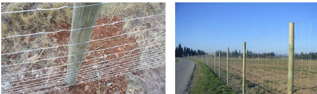
Tendido de malla gradual y cerca ganadera en carreteras.
