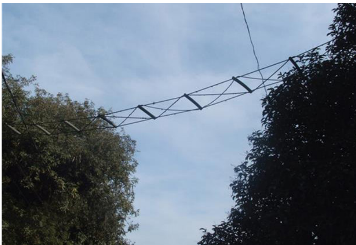
Paso aéreo para fauna arborícola mediante entramado de cuerda y tubos plásticos colocado en caminos de bajo tránsito.
