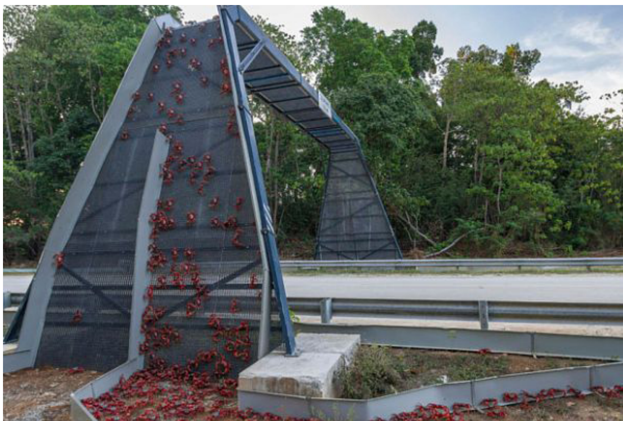
Ejemplo de paso para fauna temporal desmontable para cangrejos migratorios en la Isla Navidad, Australia (fuente: acceso abierto de internet).
