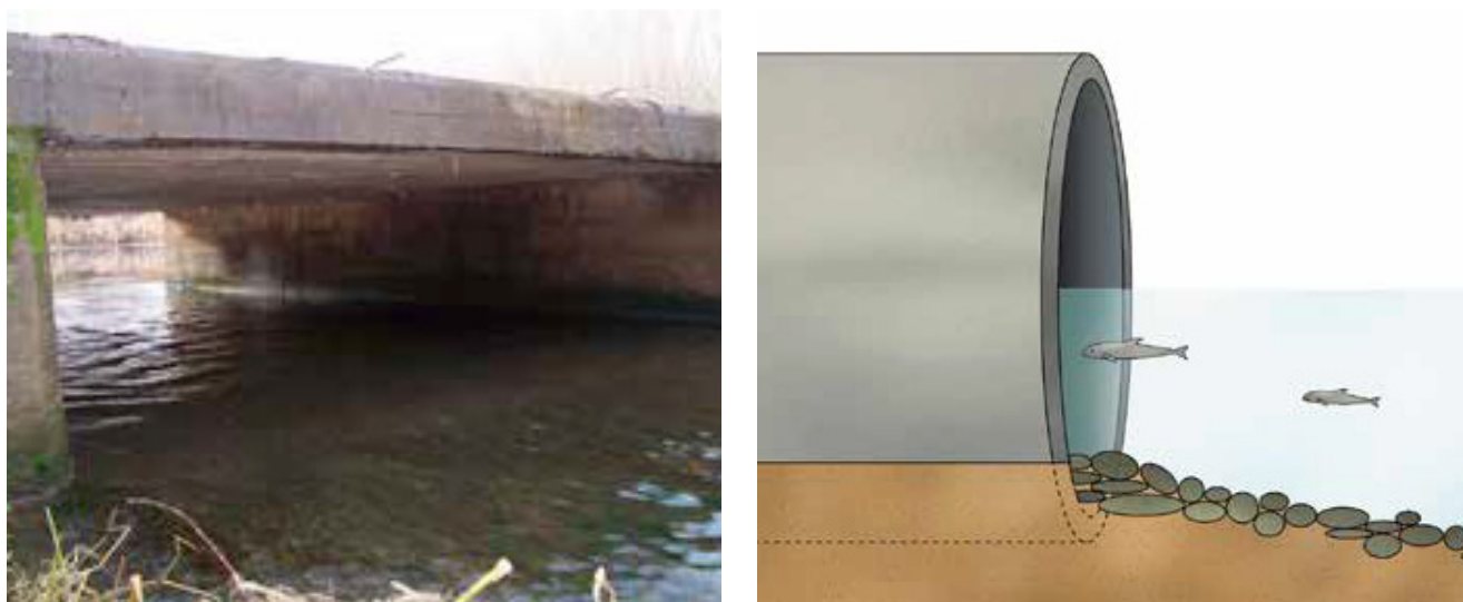
Pasos de fauna para vertebrados acuáticos (tomado de Notas Técnicas del CIREF, n° 7, 2013).
