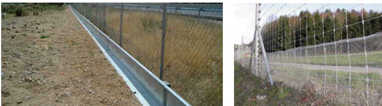
Tendido de malla ciclónica con rodapié metálico continuo y rodapié de malla metálica cerrada para protección de especies de mamíferos pequeños, anfibios y reptiles. 77
