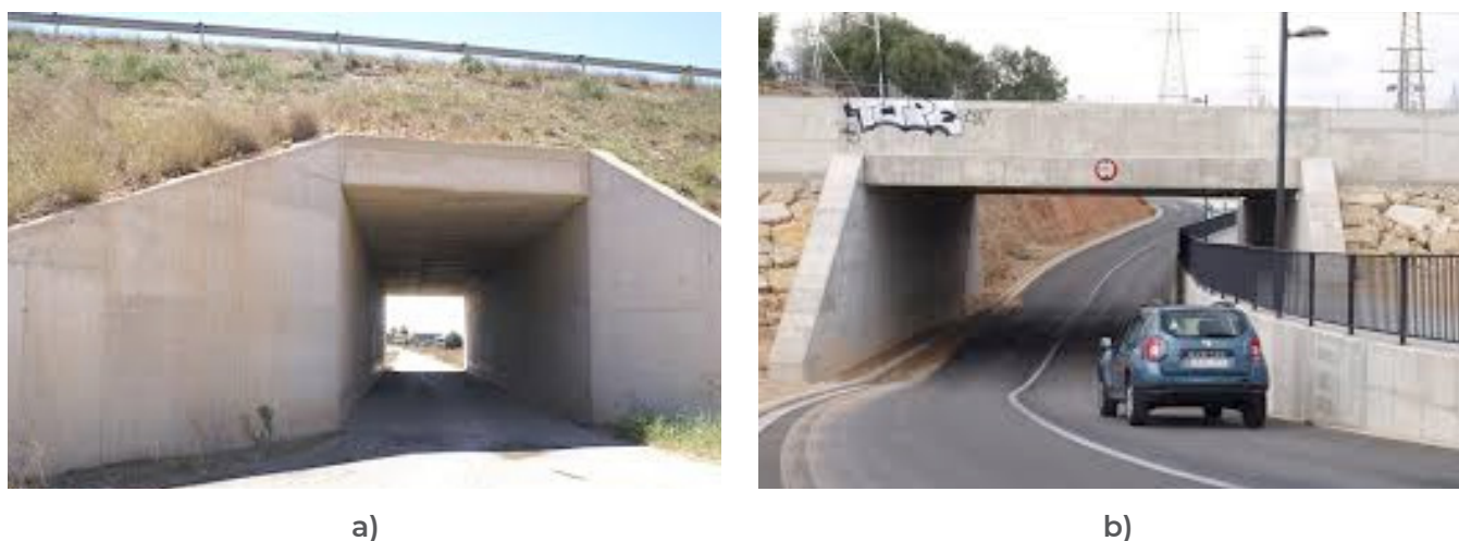
Vistas de pasos para ganado en carreteras. a) Paso Superior Ganadero (PSG) y b) Paso Inferior Ganadero (PIG).
