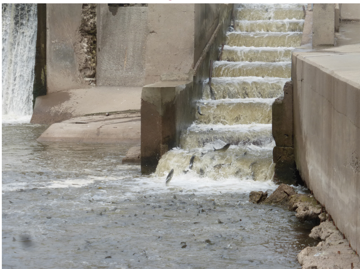
Ejemplo de escalera de peces utilizada como paso para fauna acuática en lugar de alcantarillas de caída. 76
