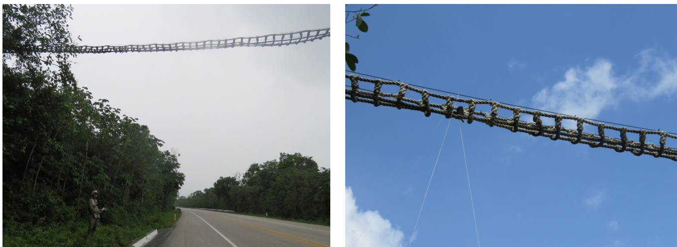
Paso aéreo para fauna arborícola ubicado en la Autopista Kantunil-Cancún, Quintana Roo (fuente: Grupo Selome, S.A. de C.V.).
