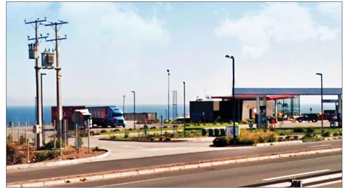
Figura - V.- Vista área general del lado poniente de la estación de servicio entre Caleta Totoralillo y Quilimarí-Ruta 5.
