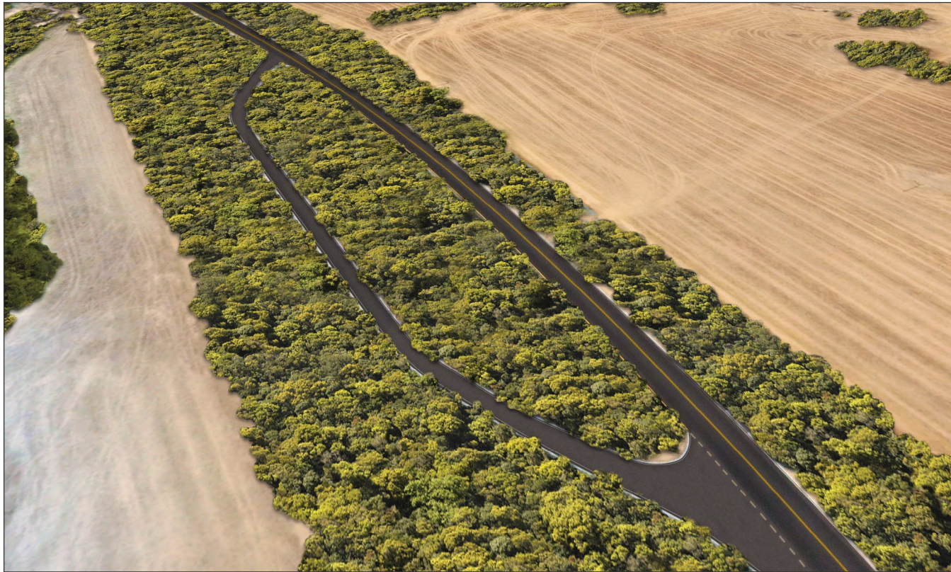
Figura - VIII.- Bahía de Estacionamiento, Albany Hwy 30 en Australia.
