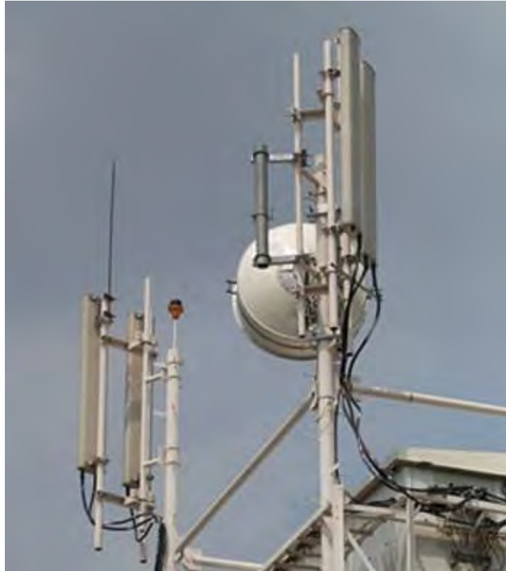
F-08 Antena para Red WiMax Protocolo Estándar 802.16
