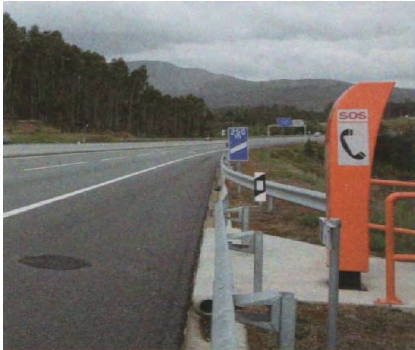
F-25 Bahía de Emergencia para Sistema de Asistencia (Poste SOS)
