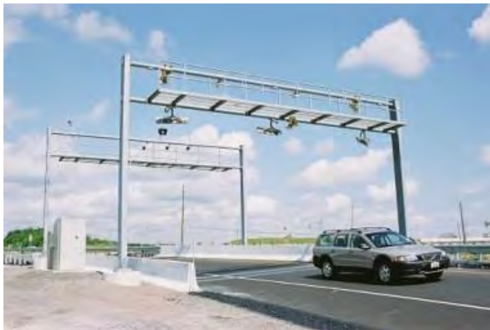
F-32 Plaza de Cobro de Flujo Libre (Free Flow) sin detención de vehículos
