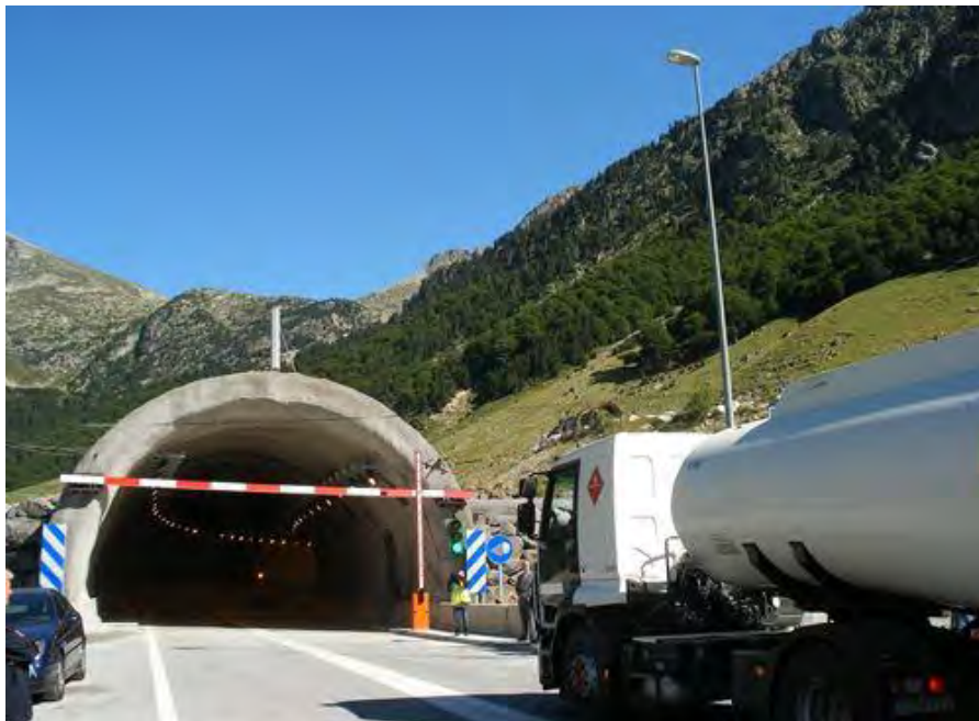
F-21 Control de Gálibo en Ingreso a Túnel
