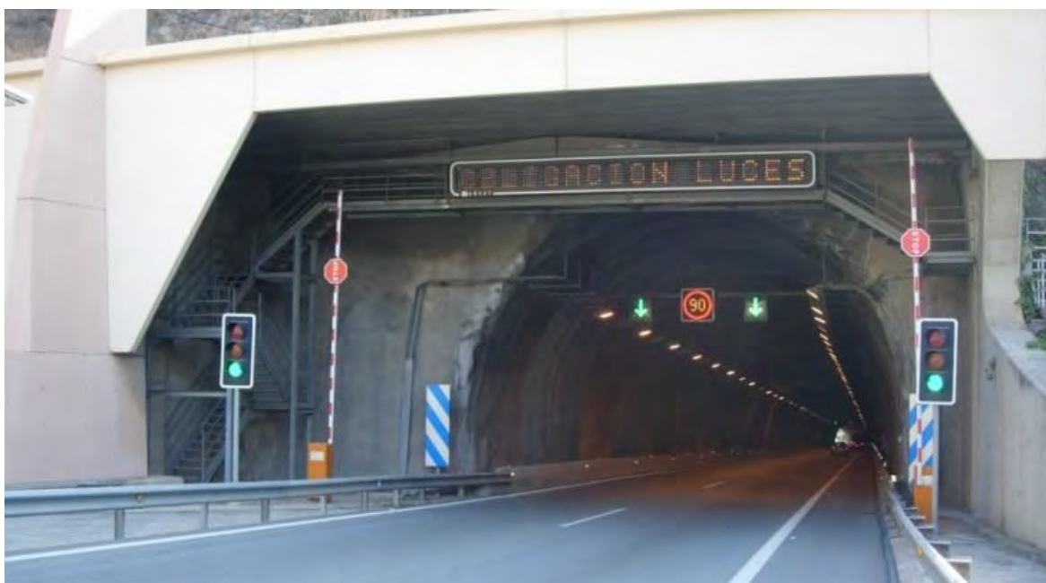
F-59 Boca de túnel con cierre automatizado y señalamiento
