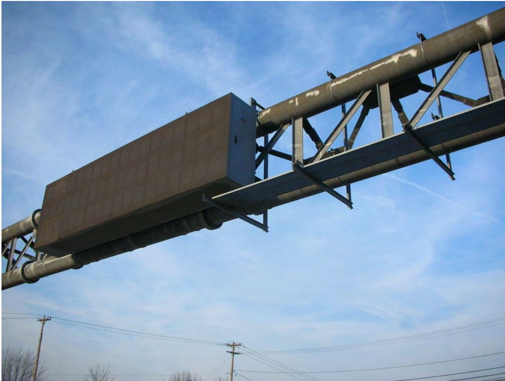
Panel de Mensajes Cambiables en Formato de Pórtico
