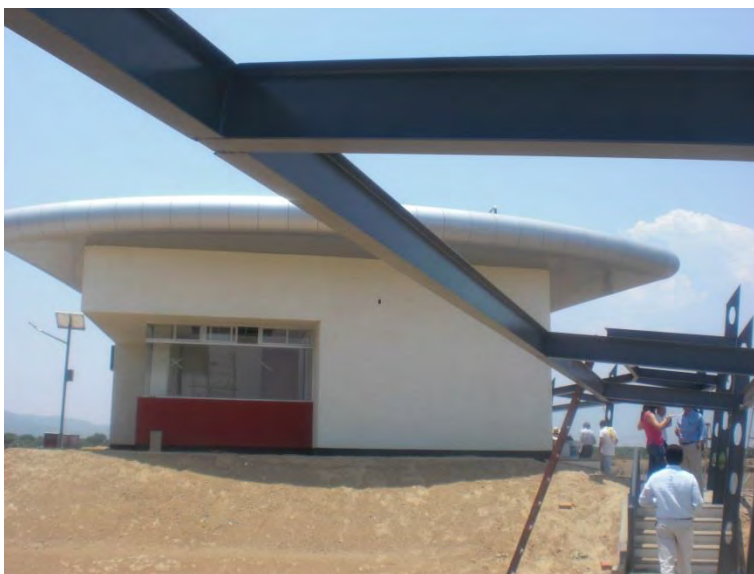
F-01 Edificio Centro de Control y Operación Carretera Guadalajara - Colima
