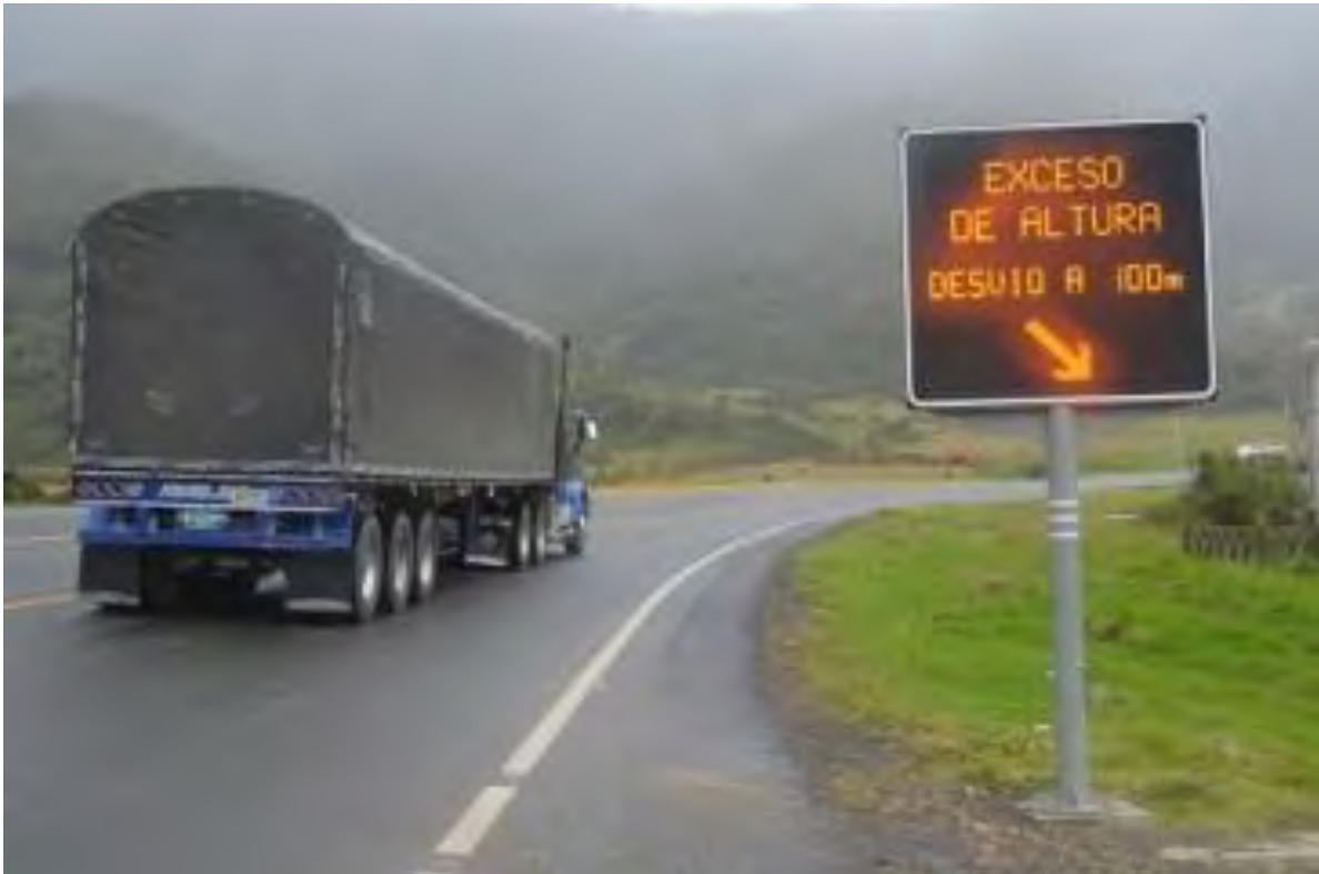
Señalamiento en Control de Gálbo Automatizado
