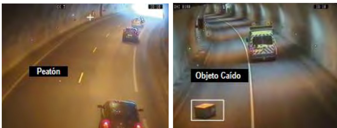
F-54 Imágenes de subsistema DAI en túneles
