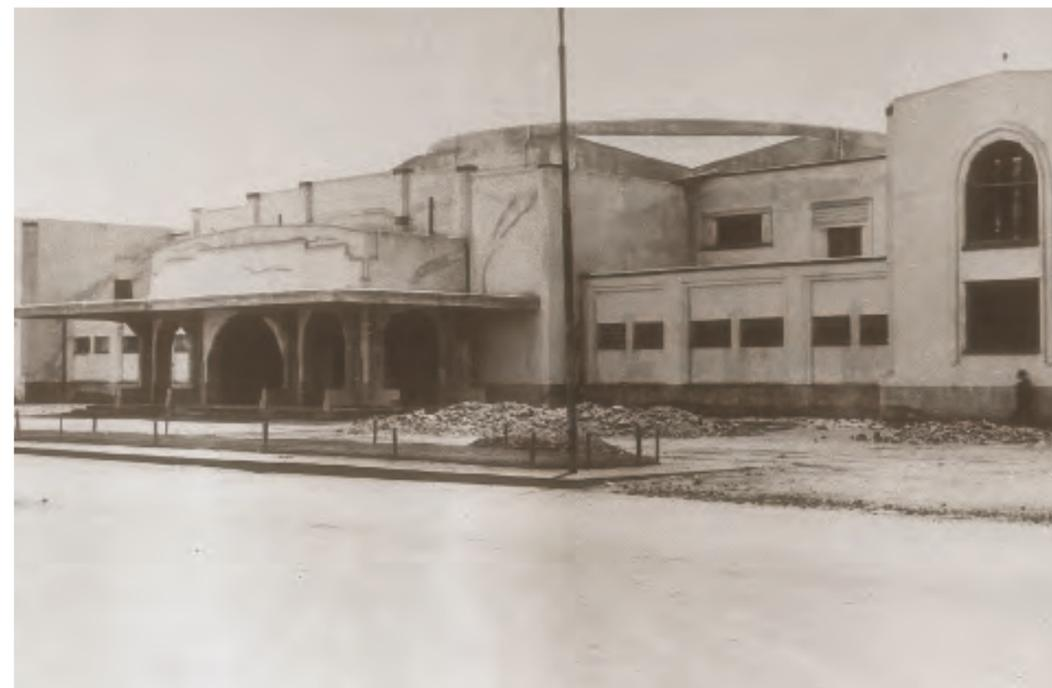
Daños causados en el edificio de la terminal del Puerto Central Aéreo por el terremoto que sufrió la Ciudad de México el 3 de junio de 1932, con grado 8.1 en la escala de Richter.
