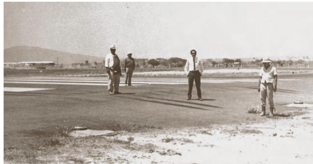
Los técnicos revisan el umbral de una pista muy corta: hay marcas de toques antes de la superficie pavimentada.
