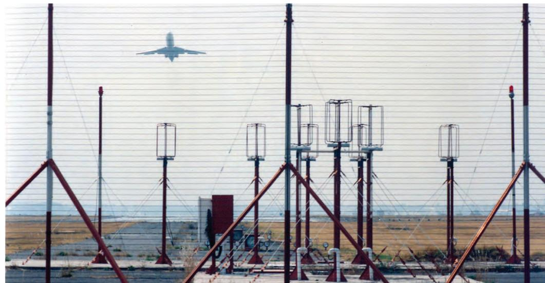
Antenas del sistema de aterrizaje por instrumentos del AICM, de gran precisión.
