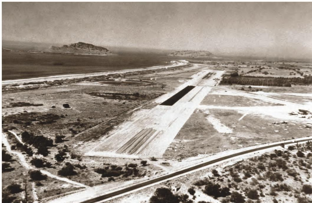
*Trabajos en la pista del Aeropuerto de Mazatlán al ser reparada por el "efecto jet" en su superficie.*
